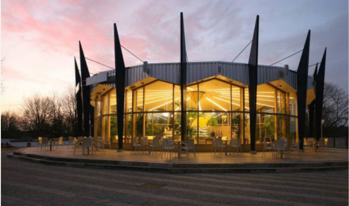
Erfurt, ega-Gelände, Rundbau nach der Sanierung (Bild: Spangenberg + Braun)
