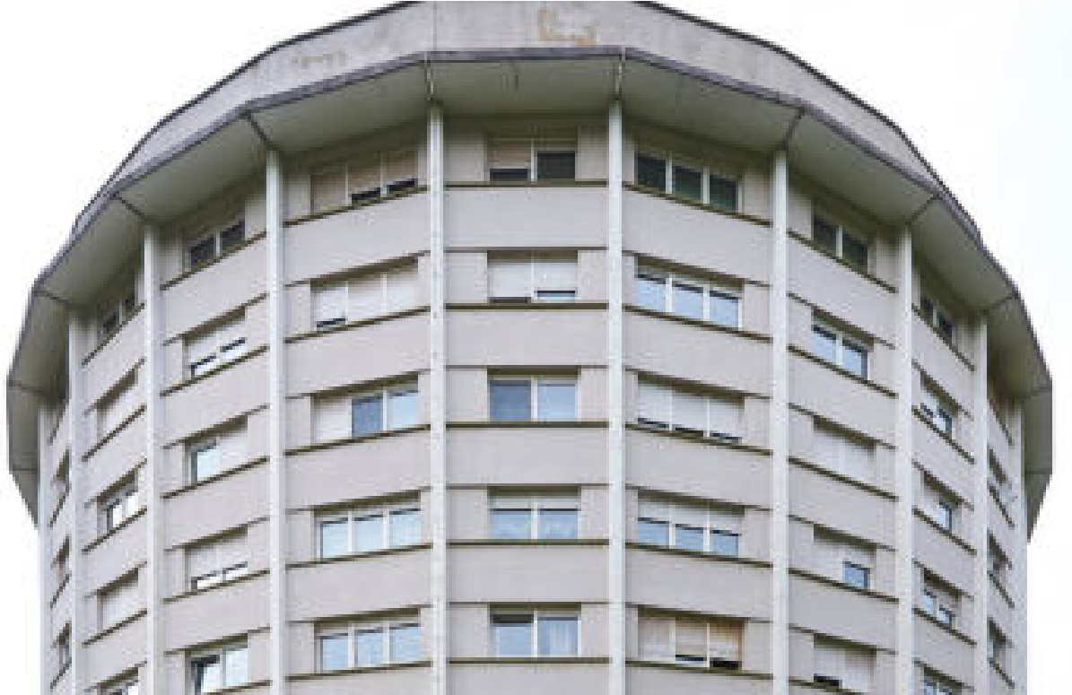
Saarbrücken, Habitat am Stockenbruch (Bild: Marco Kany)
