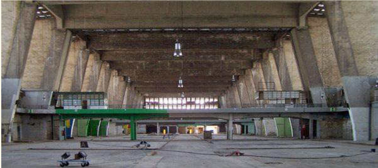
Frankfurt am Main, Großmarkthalle (Bild: Urmelbeauftragter, bearbeitet von Dontworry, GFDL oder CC BY SA 3.0, 2009)
