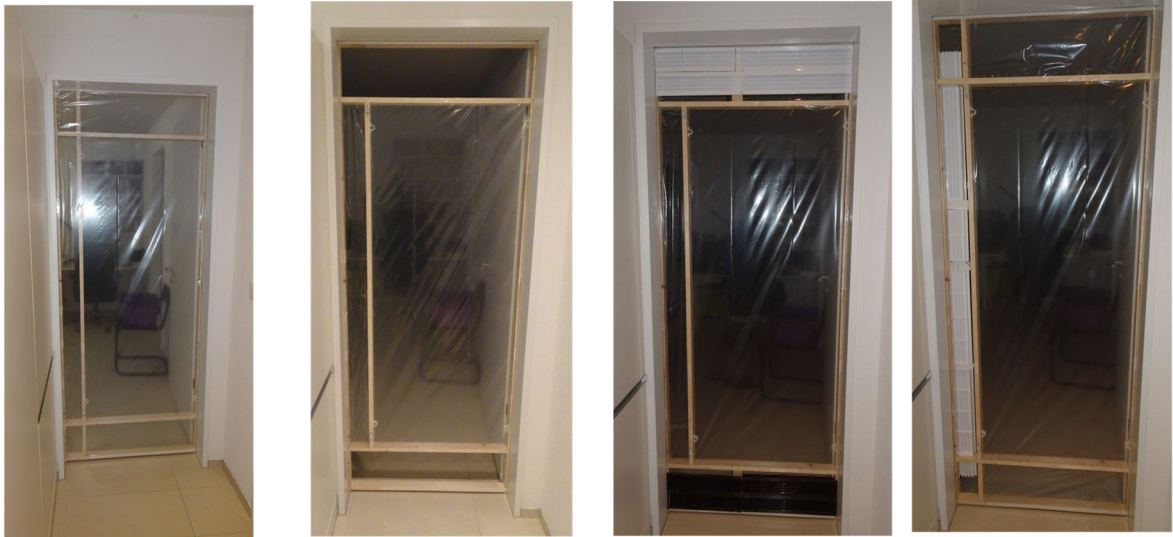
Abbildung 7: Element für Türersatz. Aufbau verschiedener Varianten von Überströmquerschnitten
