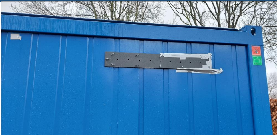
Figuur 34 Foto van ventilatieopening in de container voorzien van een gleuf met 9 gaatjes.
