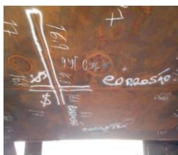
Figura 1 Marcação de espessura por ultrassom
