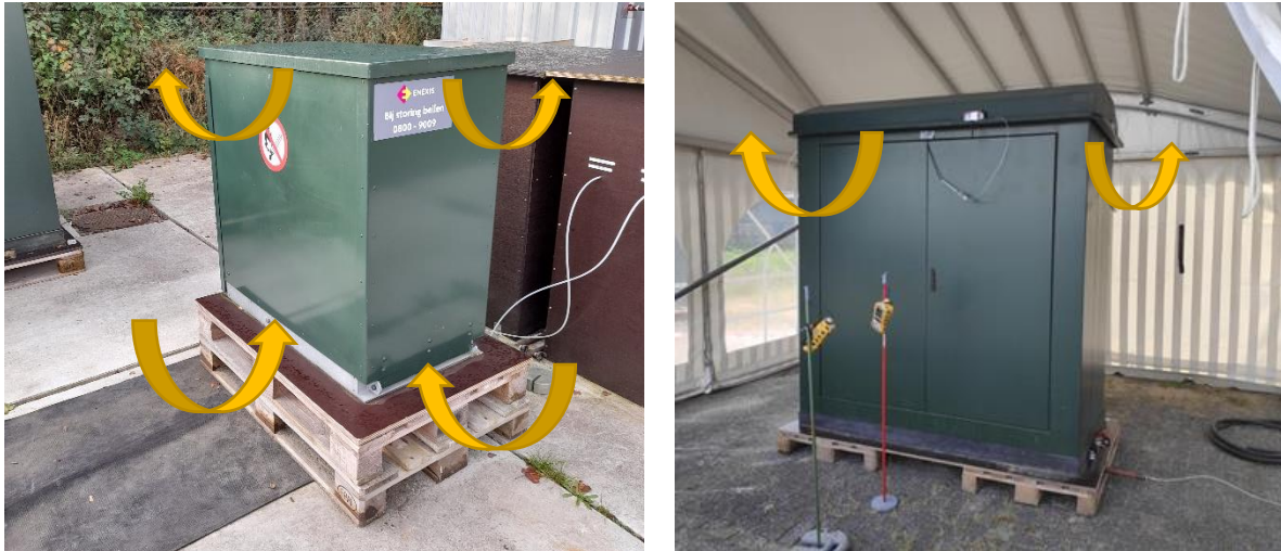
Figuur 17. Kleine behuizing (1/2m 3 kast) links en grote behuizing (4m 3 kaststation) rechts
