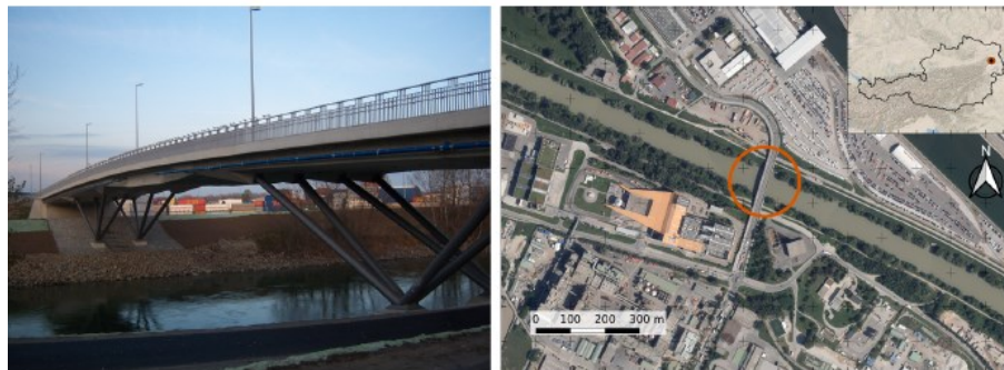
Figure 2.28. Analysis of Seitenhafen bridge using space borne data (Schögl et al. 2021).
