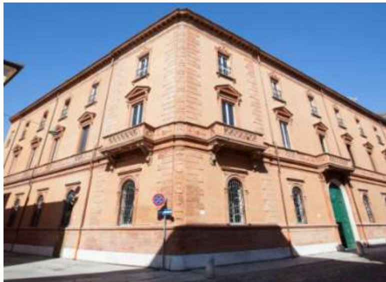
Figure 10: Prospetti Principali Sud ed Est di Palazzo Gulinelli a Ferrara. Source: https://gbcitalia.org/documents/20182/1263963/gbc_progettomese_gulinelli_02.jpg/7bf9ef66-0cd9-4c5c-ad34-5ea75b6a3ce2?t=1580297096503
