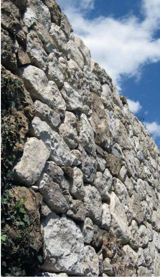
Fig.3 Muro ricostruito in contrada Mattietti, Comune di Valstagna
