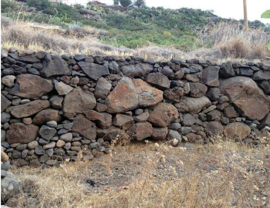
Fig.2 Isola di Filicudi: muri in pietra a secco caratterizzati dalla presenza di blocchi di lava andesitico- basaltica di grandi dimensioni incastonati tra pietre di medie e piccole dimensioni (A. Sardella, 2016)
