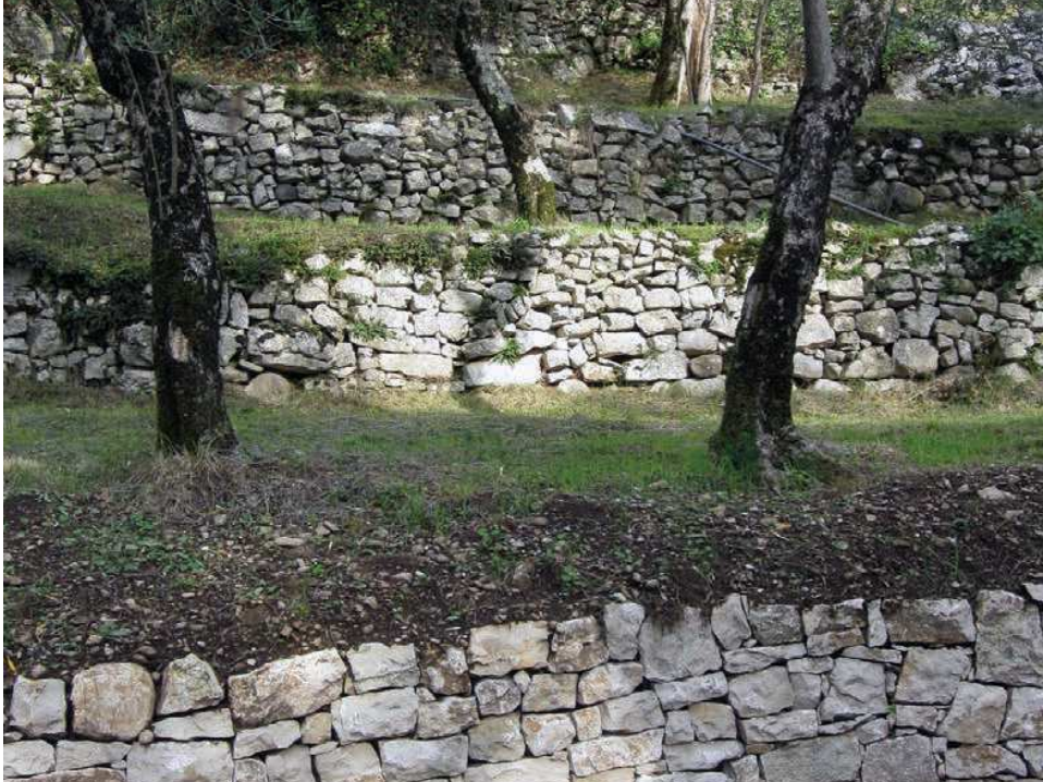
Fig.2 Rifacimento di tratti di muro a secco, utilizzando le pietre del posto (foto A. Perazzolo)
