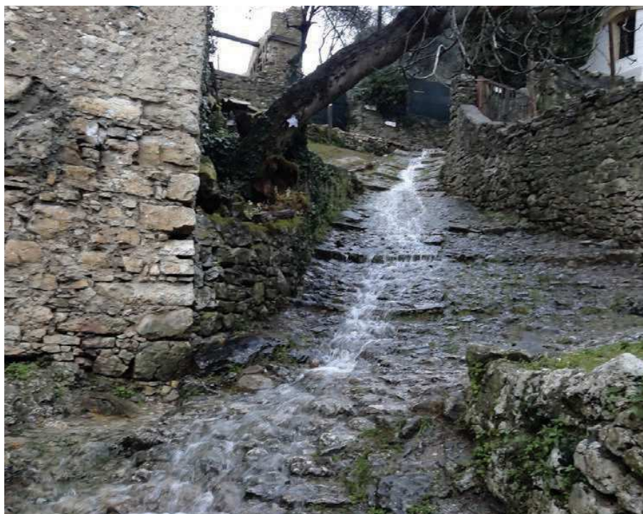
Fig.1 Mulattiera selciata con funzione di canale di scolo delle acque di scorrimento superficiale (Foto: A.Perazzolo)
