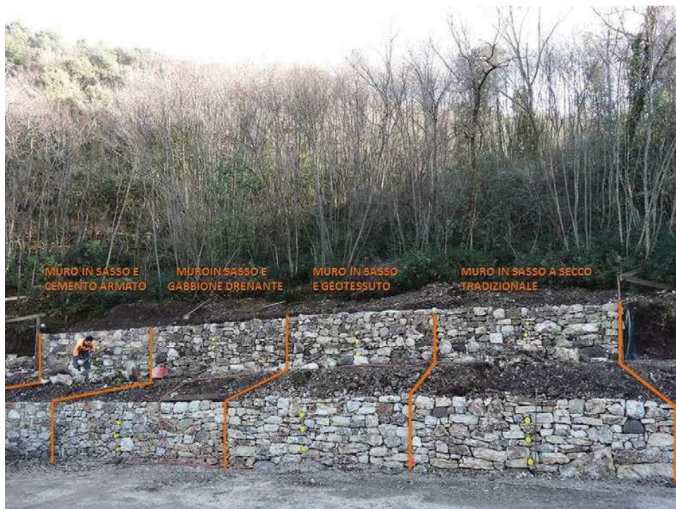
Fig.3 Cantiere pilota con indicazione delle tipologie di muro realizzate (Foto: A. Perazzolo)
