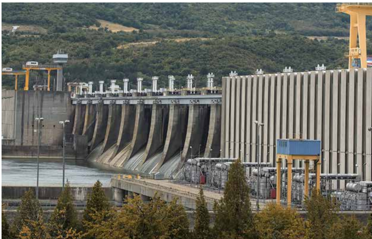
Fig. 11 Barajul Porțile de Fier I situat la km 943 al Dunării. Construcția acestuia a schimbat regimul de curgere al Dunării în amonte, de la fluviu la lac de acumulare. Regimul de lac de acumulare se manifestă până la Belgrad
