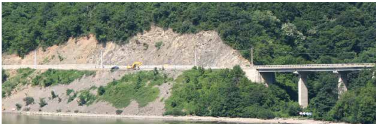
Fig. 23 Flișul de Severin, Pânza de Severin, aflorat la viaductul Grăniceri, în amonte de intrarea în Cazanele Mari. Vedere de pe malul drept al Dunării
