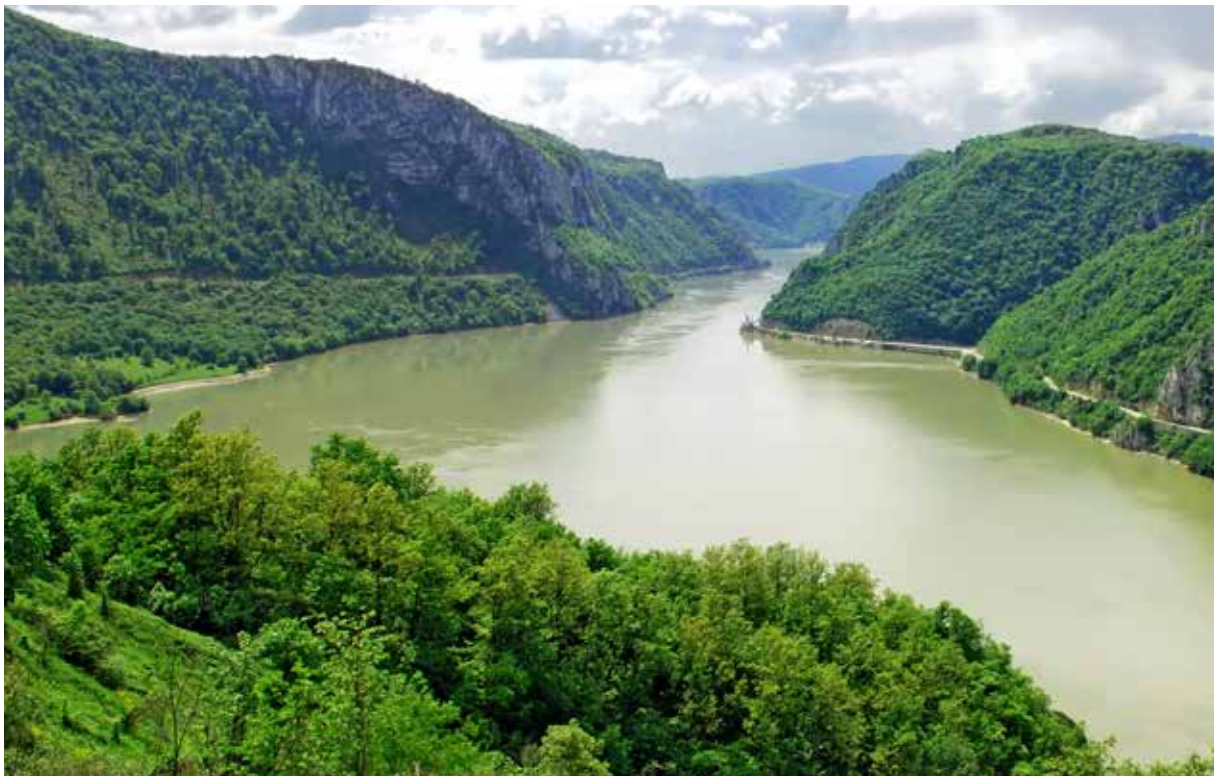
Fig. 2 Dunărea la Cazane după umplerea lacului de acumulare Porțile de Fier I. Aspect din anul 2018 (nivelul actual al apei a fost atins după 1972)
