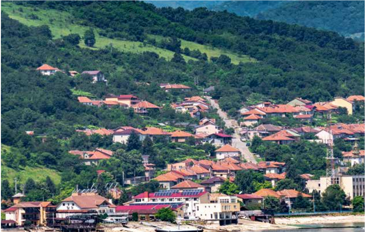
Fig. 54 Municipiul Orșova a fost strămutat în anul 1968 pe actualul amplasament. Orașul vechi a fost acoperit de ape în anul 1971
