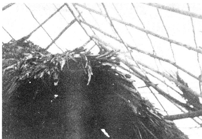
La estructura del techado de la vivienda nueva es montado sobre el techo de la otra sin demoler.
