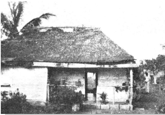
Vivienda con medio portal donde se observa la alineación entre las puertas delantera y trasera para facilitar la ventilación interior.
