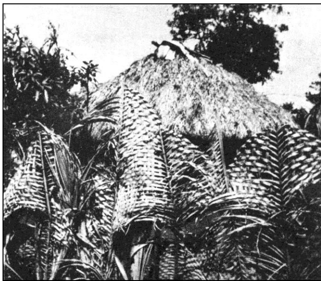
Cercas recubiertas con pencas de palma entretejidas.
