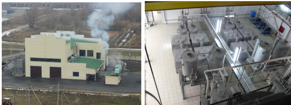
Рис.10. Фото когенерационной электростанции на лузге подсолнечника в ООО «Центр «СОЯ», ст. Тбилисская, Краснодарский край. Источник: yandex.ru/images.
