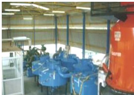
Рис. 4. Газогенератор 250 кВт, Flex Technologies Inc., Индия
