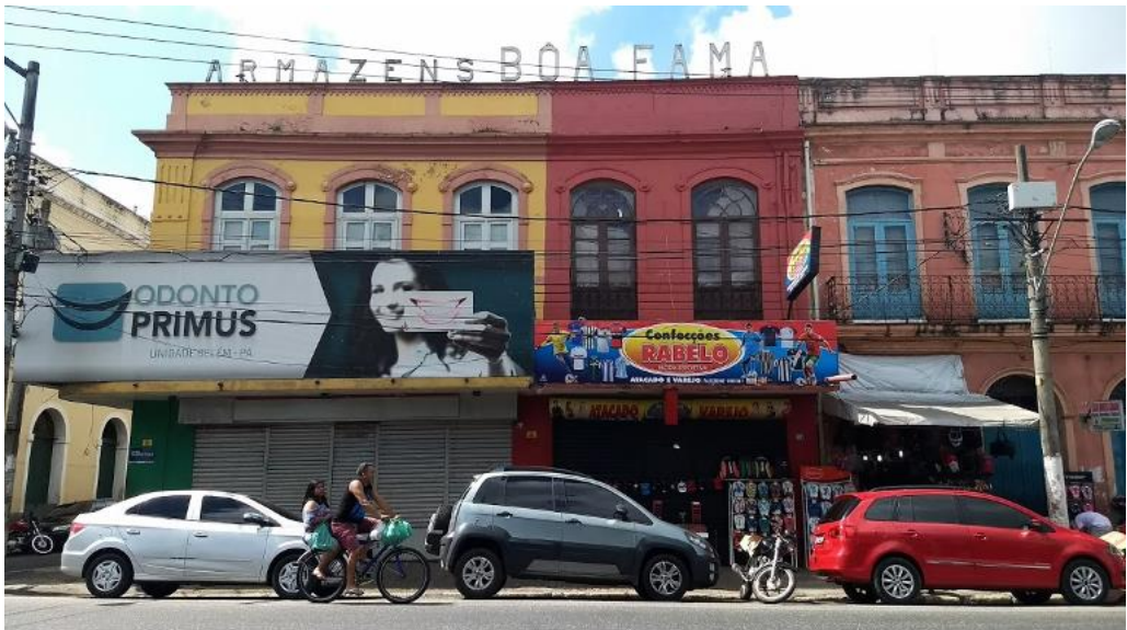
Figura 11. Fachadas comerciais de casarões antigos, 12 de agosto de 2018. Foto de Victória Costa.
