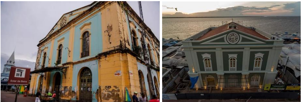
Figura 9. Esq.: Solar da Beira antes da reforma. Foto: Fernando Sette (Comus). Dir.: Solar da Beira após a reforma. Foto: Expedição Pará.
