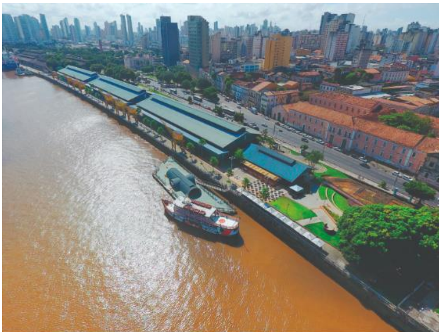
Figura 6. Vista aérea da Estação das Docas. Fonte: http://www.estacaodasdocas.com/
