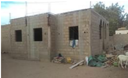
Photo 10 – Maison en parpaings de ciment en construction depuis 2011 sur la concession d'une famille interrogée dans la région du Fouta-Toro (source : auteur).
