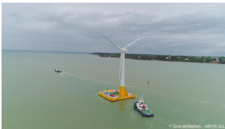
FIGURE 10 : REMORQUAGE DE L'ÉOLIENNE JUSQU'AU SITE SEM-REV.
