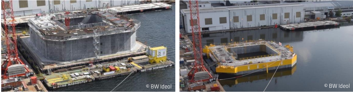
FIGURE 5 : PHASE DE CONSTRUCTION DU FLOTTEUR AU PORT DE SAINT-NAZAIRE.
