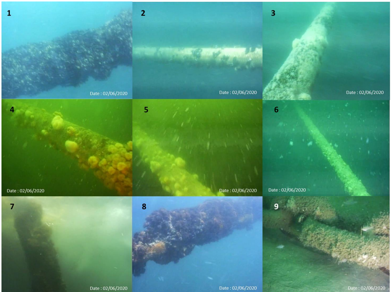
FIGURE 41 : PLANCHES PHOTOGRAPHIQUES REPRESENTATIVES DE LA BIOCOLONISATION DES LIGNES D'ANCRAGES (© BW IDEOL & CN – SEM-REV).
