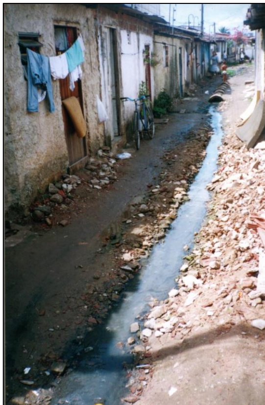
Foto Nº 13. Esgoto a céu aberto, 2001
