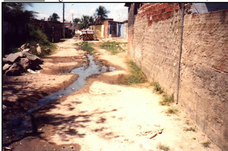
Foto Nº 12. Esgoto a céu aberto na Rua Carlos Gomes, 2001
