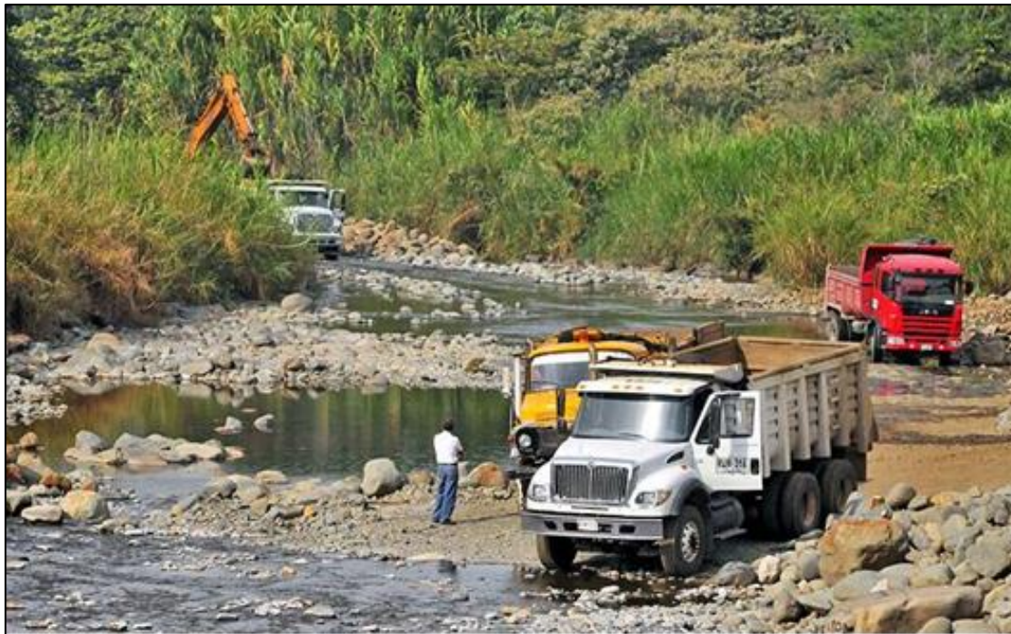
Foto N° 20. Extracción de material de arrastre en el río Pance
