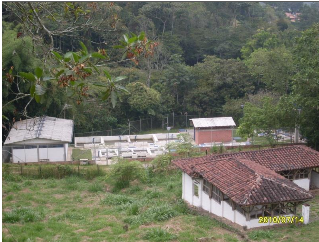
Foto N° 7. Etapa final PTAP
