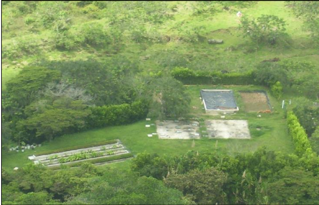
Foto N° 5. Construcción PTARD Fase 1
