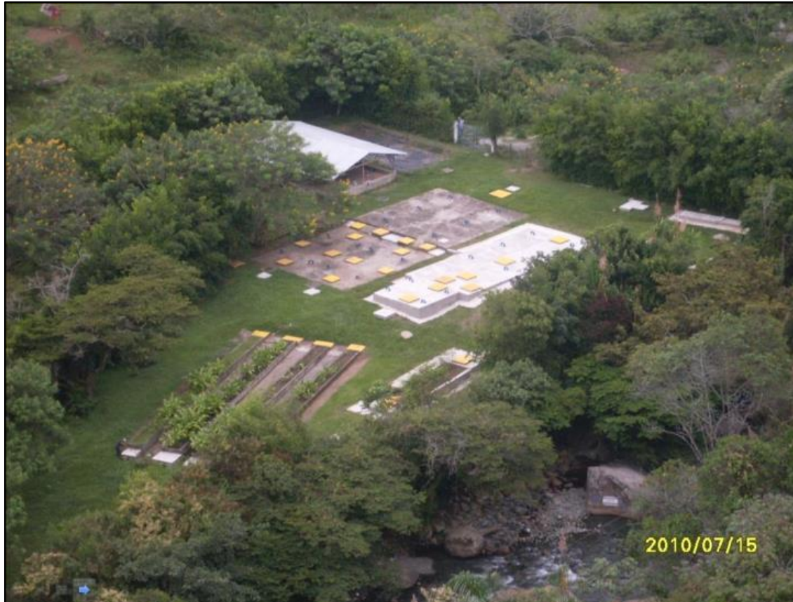
Foto N° 9. Ampliación PTAR - Fase II
