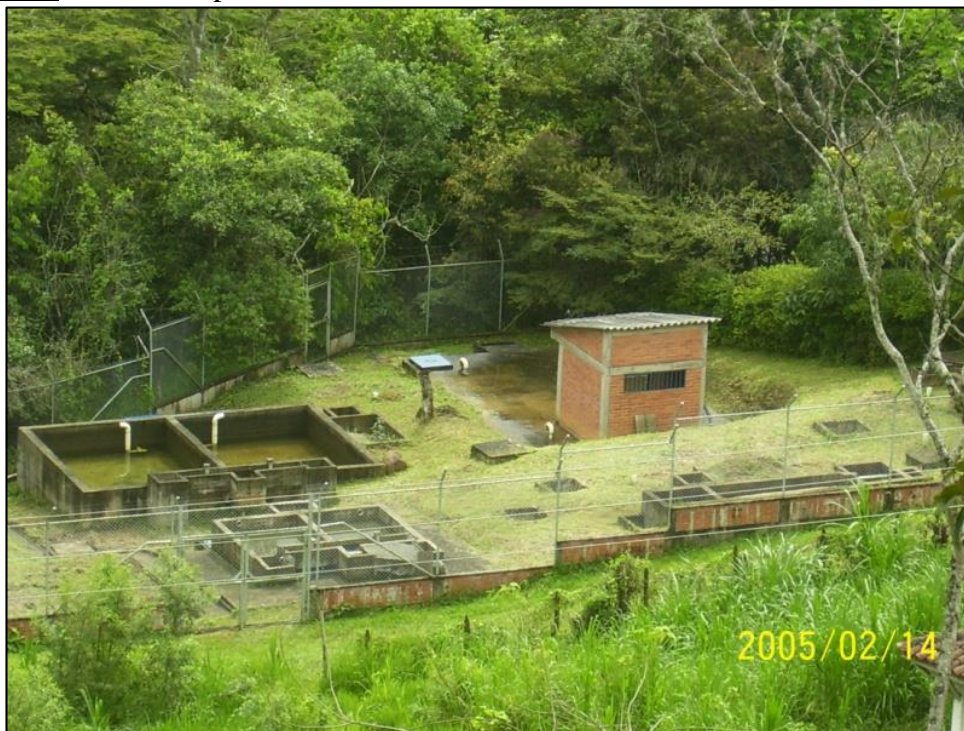
Foto N° 6. Primera etapa PTAP
