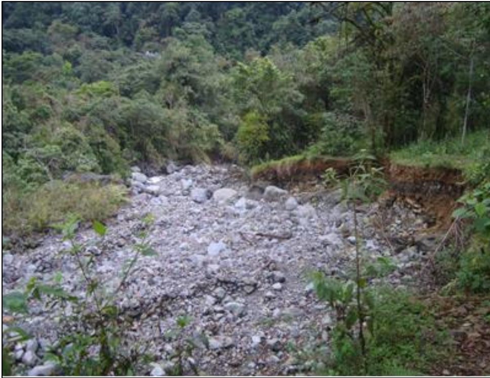
Foto N° 19. Cambio de cauce del río Pance - Parte alta
