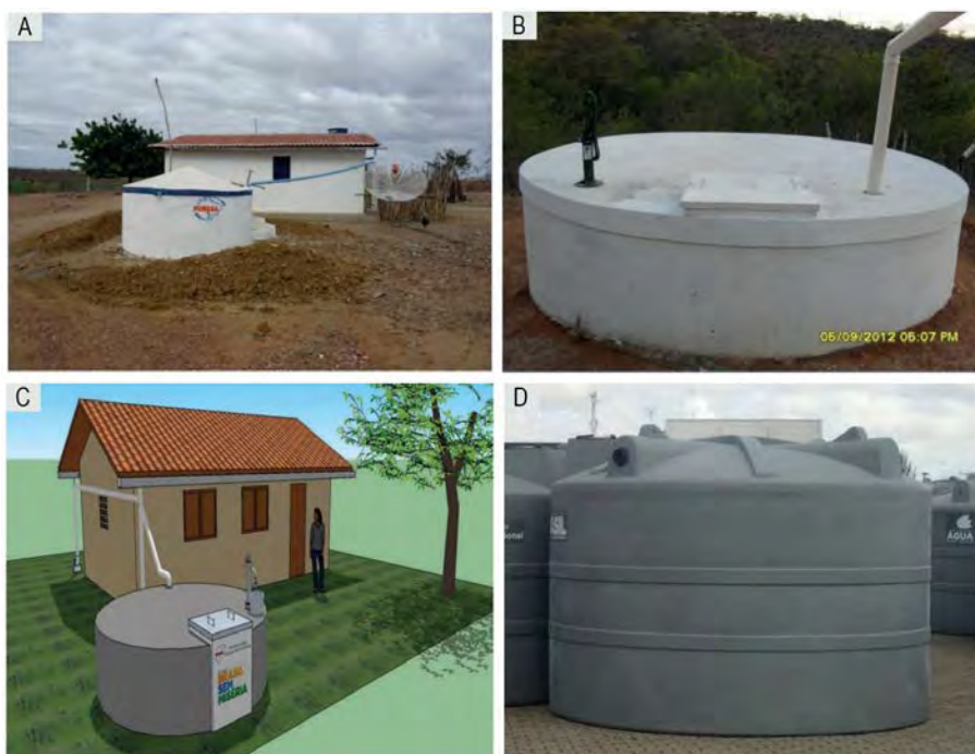
Figura 2 – Tipos de cisternas comumente utilizadas: (A) em placas de concreto com bomba manual de PVC; (B) em placas de concreto com bomba manual; (C) com dispositivo de descarte – Padrão Funasa; (D) cisterna em PEAD. Fonte: Adaptada de BRASIL (2015).
