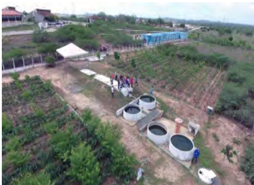
Figura 14 – Visão panorâmica dos sistemas de tratamento de esgoto Fonte: Arquivo de propriedade do INSA (Foto: Felipe Lavorato).
