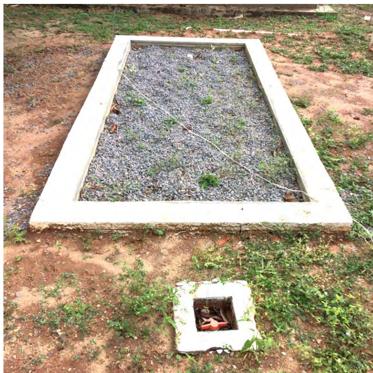
Figura 8 - Vista superior do sistema alagado construído Fonte: Arquivo dos pesquisadores (2021).
