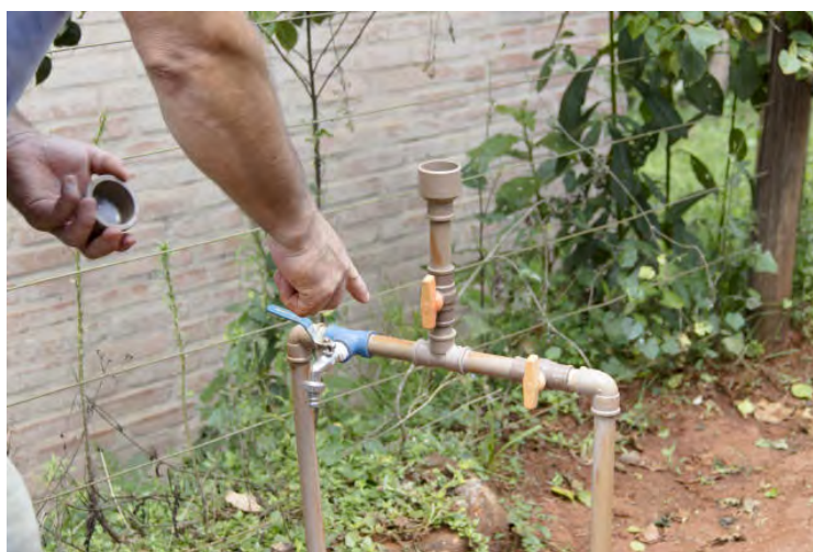
Figura 7 – Clorador implementado Fonte: Embrapa (2014).
