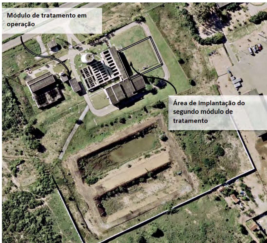
Figura 6 – Posicionamento da ETA Extremoz em relação à área de implantação do segundo módulo de tratamento Fonte: Adaptada de Gerentec (2010).
