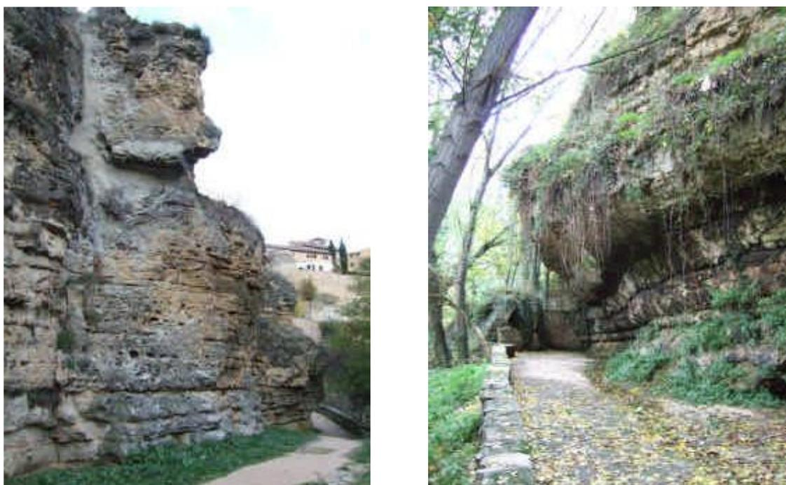
Figura 107. Cortado en roca con bloque inestable con las diaclasas selladas con gunita (izquierda) y solapo en extraplomo en un área estancial con abundantes rezumes del acuífero cárstico (derecha).
