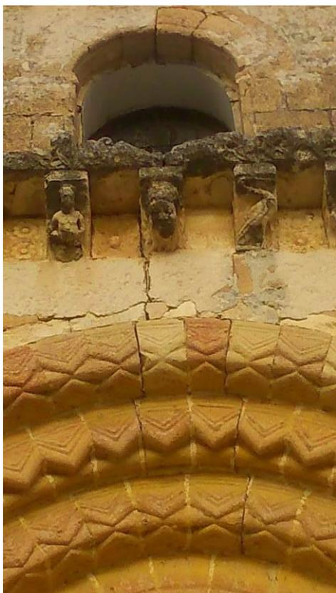
Figura 86. Fachada occidental de la iglesia de la Veracruz, con las claves ligeramente desprendidas en la ventana superior y las arquivoltas de la puerta.
