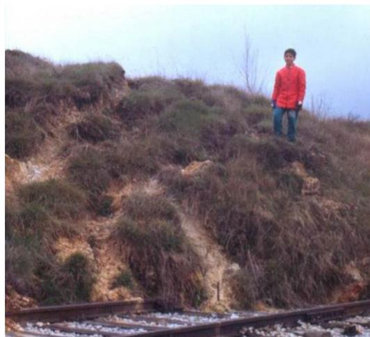
Figura 122. Pie del deslizamiento rotacional complejo en un movimiento de avance a comienzos de la década de 1980, cubriendo la vía de reserva de la estación de ferrocarril.
