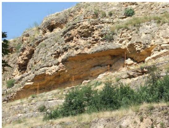
Figura 100. Zona próxima al arco de la Puente Castellana, cortada por desprendimientos en julio de 2008 (izquierda), y cornisa volada con simples puntales de sujección (arriba).
