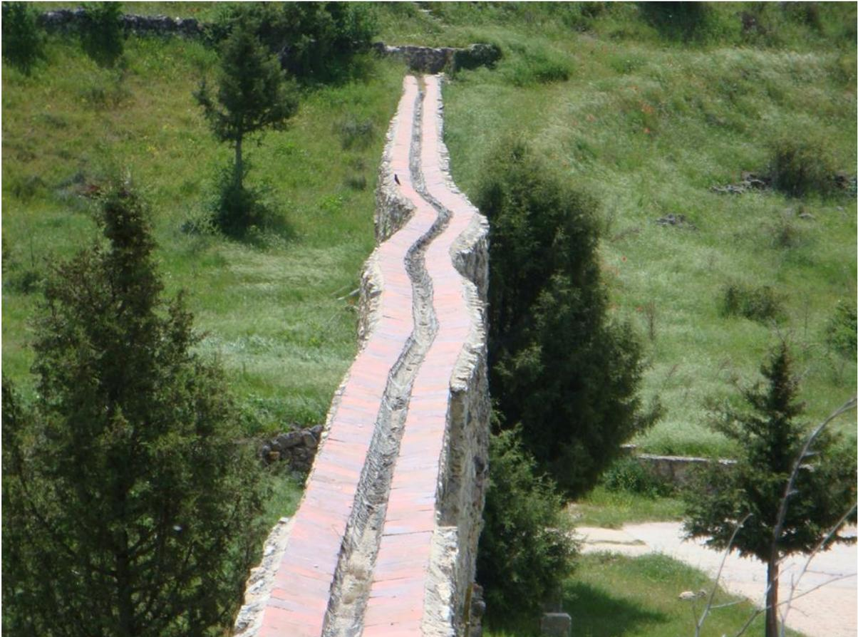
*Figura 9. Vista cenital-lateral del tramo del acueducto de Pedraza (acueducto del Caño) en su parte elevada en arquería, donde se aprecia una deformación sinusoidal en el trazado en planta, que ha sido atribuida al efecto del terremoto de Lisboa de 1755. Fuente: Díez-Herrero (2019).*
