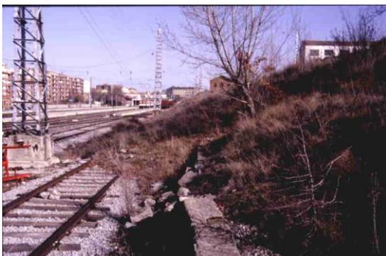
Figura 121. Pie y frente del deslizamiento rotacional invadiendo la vía de acceso al almacén de máquinas, y combando y rompiendo el murete de contención. Fotografía de mediados de la década de 1980.
