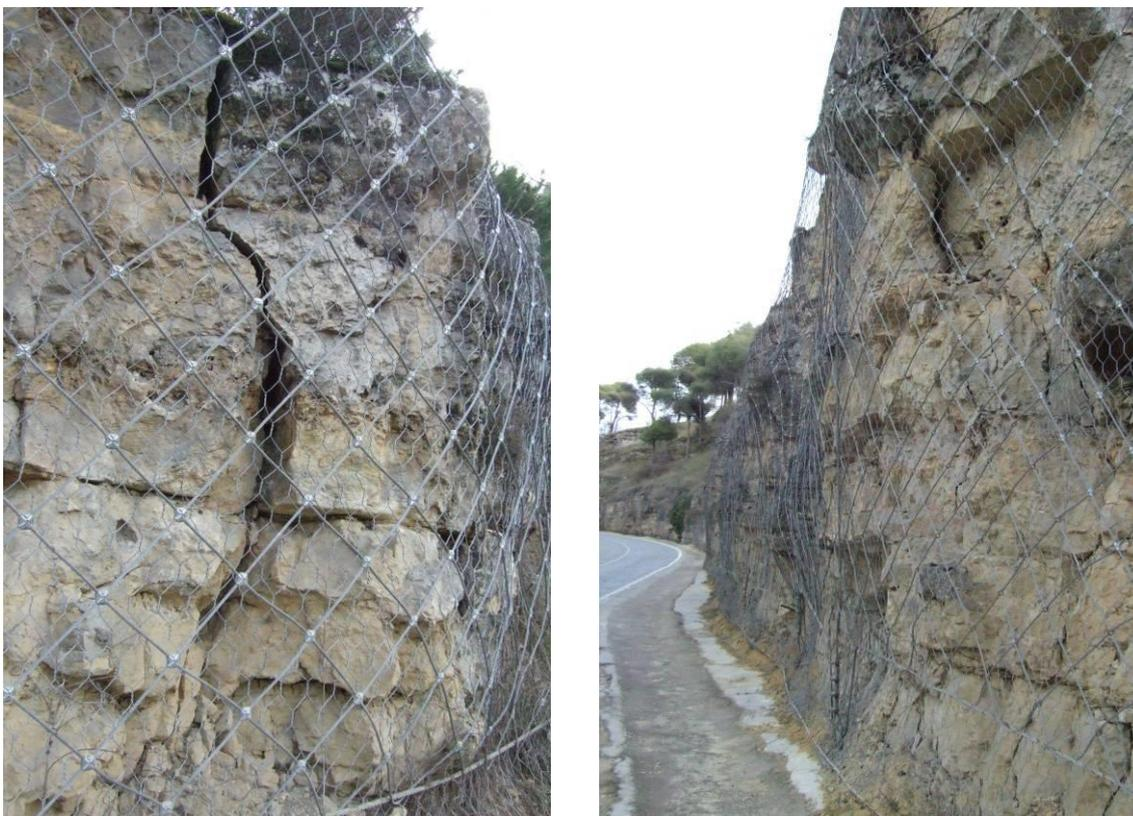
*Figura 104. Sistema de estabilización y retención 'malla-talud' implantado en buena parte de la Cuesta de los Hoyos. A pesar de estas protecciones, el 22 de noviembre de 2010 se produjo un nuevo desprendimiento en uno de los taludes, suponiendo el corte del tráfico rodado e importantes costes de reparación.*
