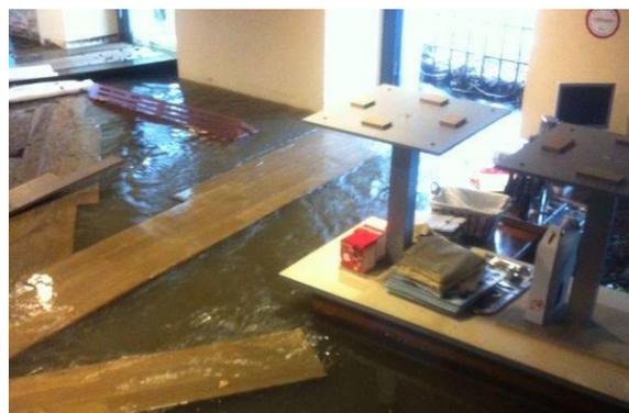
*Figura 71. Efectos de la inundación en la planta baja del bar-restaurante Ingenio Chico, con tarima flotante de madera levantada y los elementos del mobiliario sumergidos. Fuente: Segovia al Día. [www.segoviaaldia.es](http://www.segoviaaldia.es) Autor: Javier López Alarma.*
