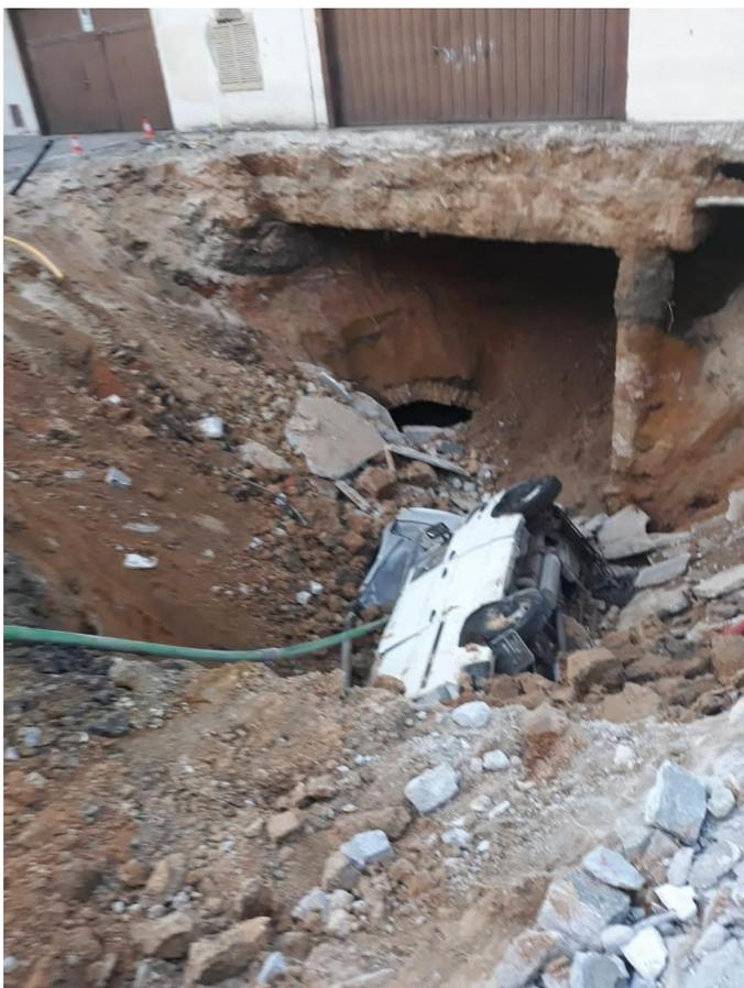
*Figura 115. Socavón en la plaza Aurelio Hernández del barrio de San Millán, formado por el colapso de la bóveda de la conducción subterránea del arroyo Clamores, tras la avenida súbita del 27 de agosto de 2019.*
