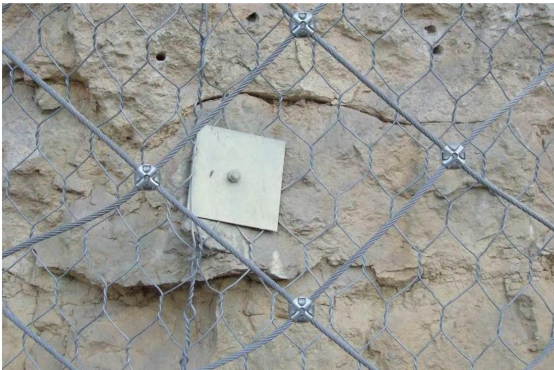
*Figura 105. Diferentes tipos de fijaciones de los taludes instalados en la Cuesta de los Hoyos, como bulonado con placas metálicas, y mallas de triple torsión de diferentes formas y pasos.*
