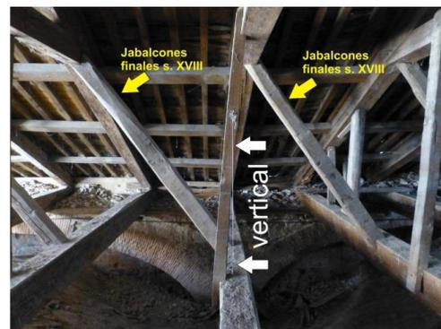
Figura 89. Inclinación respecto a la vertical de las cerchas de la cubierta de la nave central de la Catedral de Segovia, y jabalcones para apuntalar la estructura.
