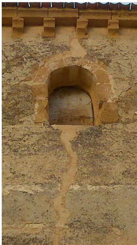
Figura 87. Fachada suroccidental de la iglesia de la Veracruz, con la reparación de grietas penetrativas y la clave de la ventana desprendida.
