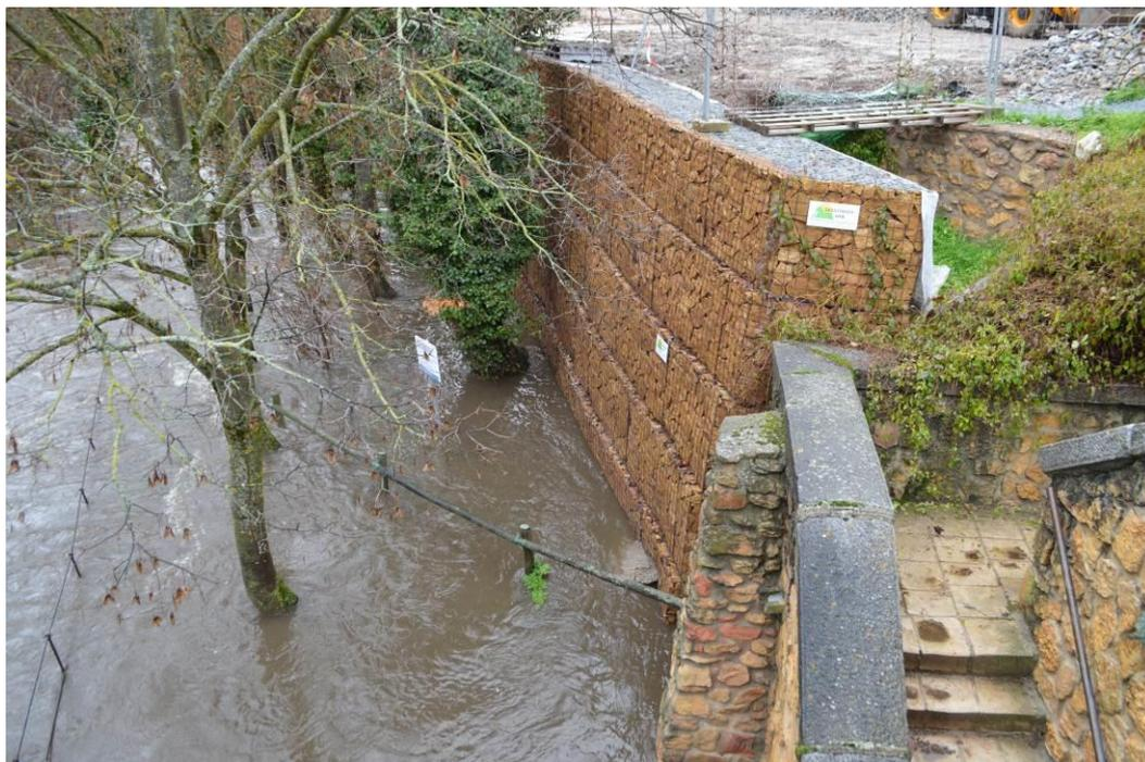
*Figura 79. Inundación del paseo paralelo al río por la margen derecha aguas abajo del puente de la Casa de Moneda, hasta la base del nuevo gavión de caja instalado para la contención del talud de una finca privada; lo que luego generaría el desmoronamiento del muro del cauce y la interrupción del camino.*
