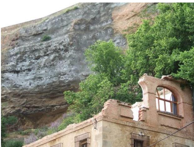
*Figura 99. Detalle del bulonado y gunitado elegido como solución técnica para la fijación de la placa de roca contigua a la zona desprendida.*
