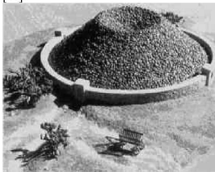
Рис. 2. Воздушный колодец Зибольда
