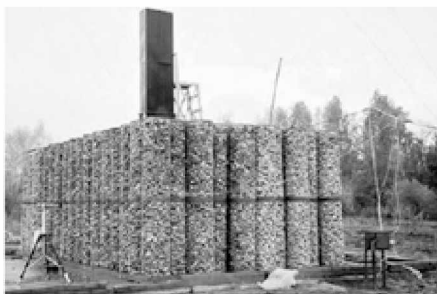
Рис. 5. Установка «РОСА». (Обнинск, Московская обл.)
