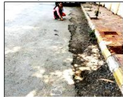
Fig. 21 Edge Breaking
