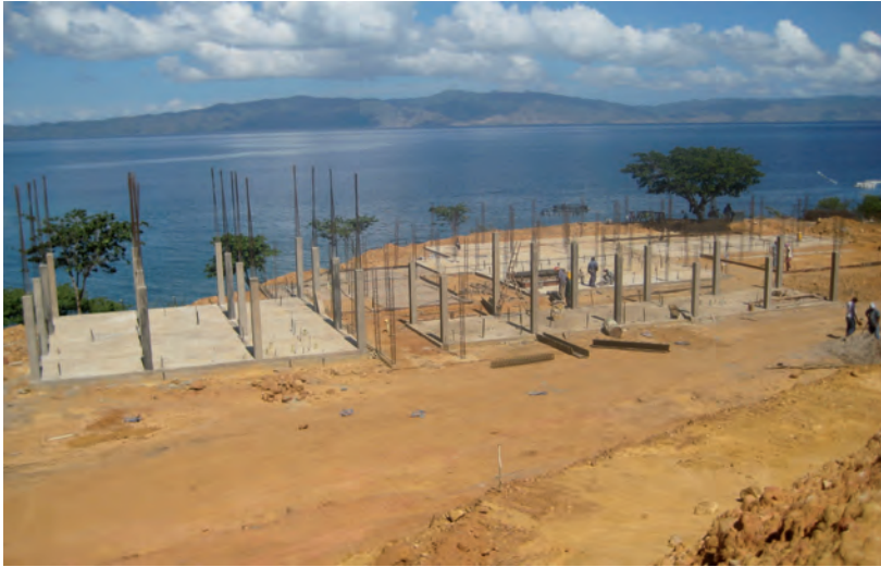
Figura 9.- Avance de la construcción del laboratorio “La Fragata” al 27-10-2008.
