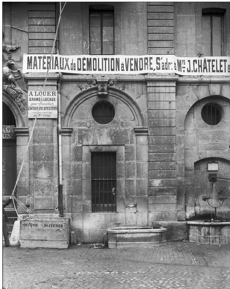
Abbildung 6 · Wiederverkauf der Bauteile aus dem Rückbau des Kornspeichers in Rive, Genf, etwa 1897.
