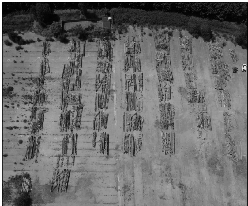
Abbildung 16 · Selektiver Rückbau der Metallkonstruktion der Halle Lustucru in Arles (a). Die Elemente werden auf dem Boden sortiert (b).
