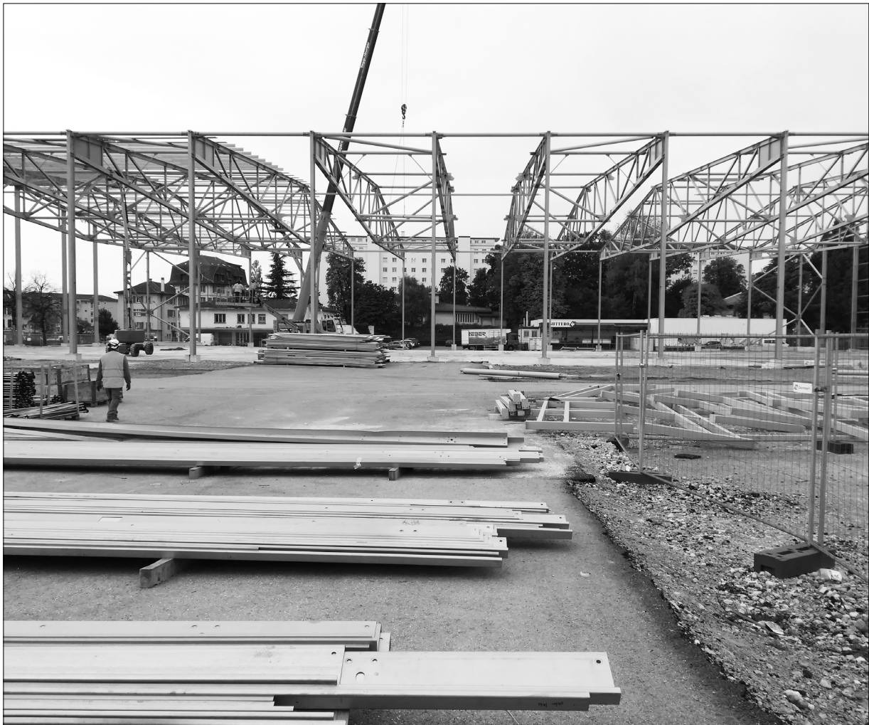
Abbildung 21 - Die innewohnenden Qualitäten von Metallstrukturen begünstigen ihre Langlebigkeit. In Lausanne wird hier eine Konstruktion zur Wiederverwendung zurückgebaut.
