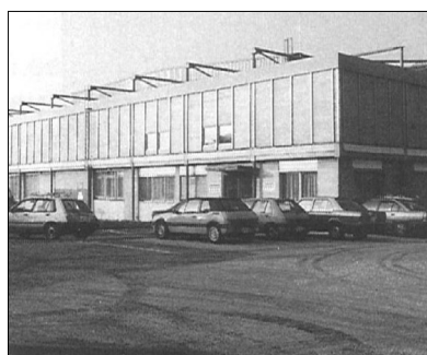
Abbildung 19 · Der Pavillon von Max Bill für die Expo 1964 in Lausanne verfolgte die Ziele der räumlichen und technischen Rückbaubarkeit (a). Am Ende der Ausstellung wurden die meisten Module von Baufirmen für den Einsatz als Produktionshallen gekauft. Ein solches Modul wurde zweimal demontiert und wieder zusammengebaut: zuerst in Yverdon für die Firma Arkina , dann in Yvonand durch die Baufirma Geilliger (b) (Gilliard 1992).
