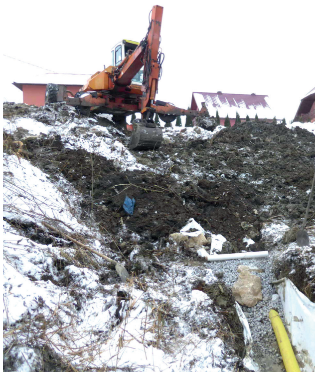
Obr. 6. Realizácia drenážno-stabilizačného rebra na lokalite Babín (foto: R. Jelínek).
