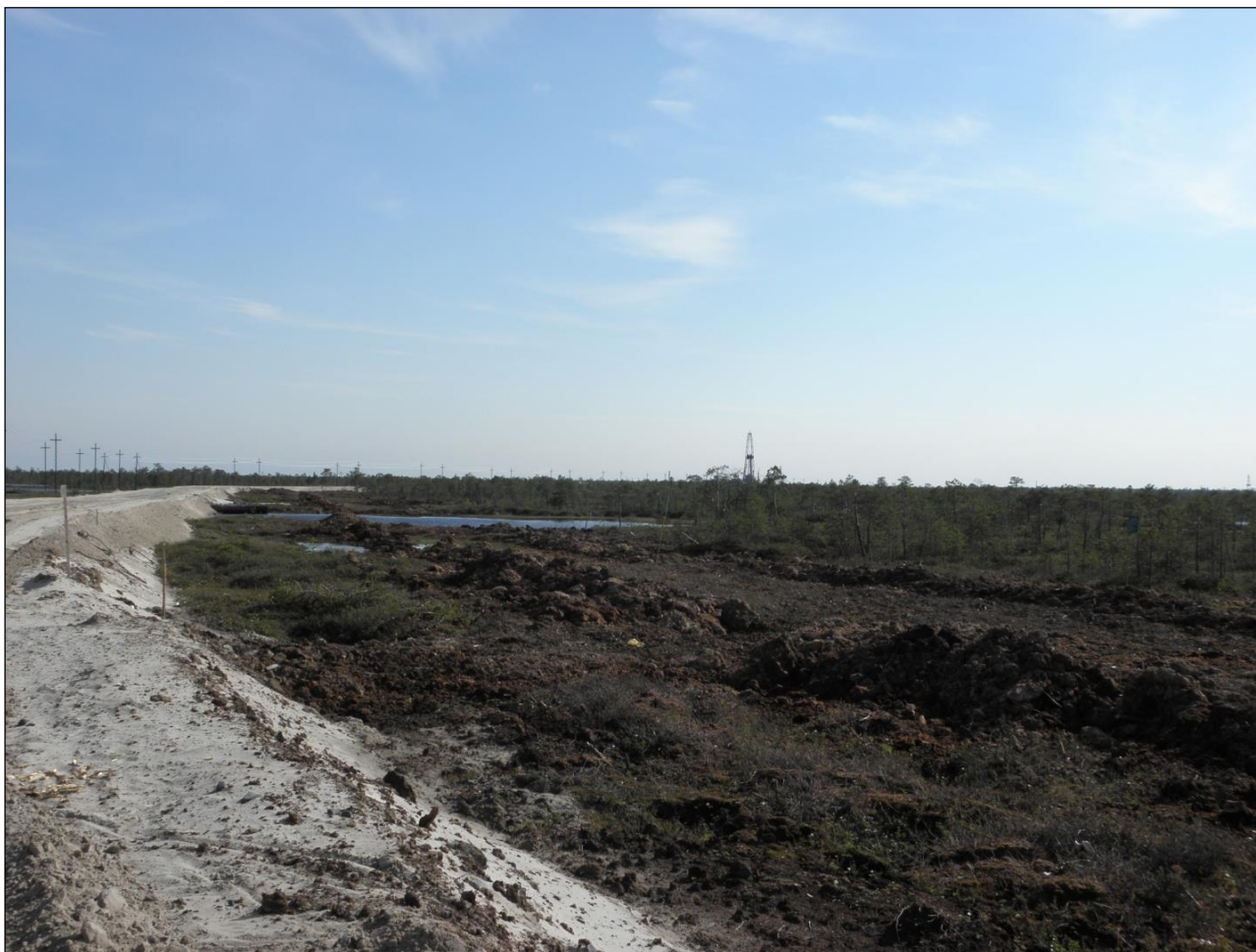
Рисунок 3. Дорога, нарушения придорожной зоны.
