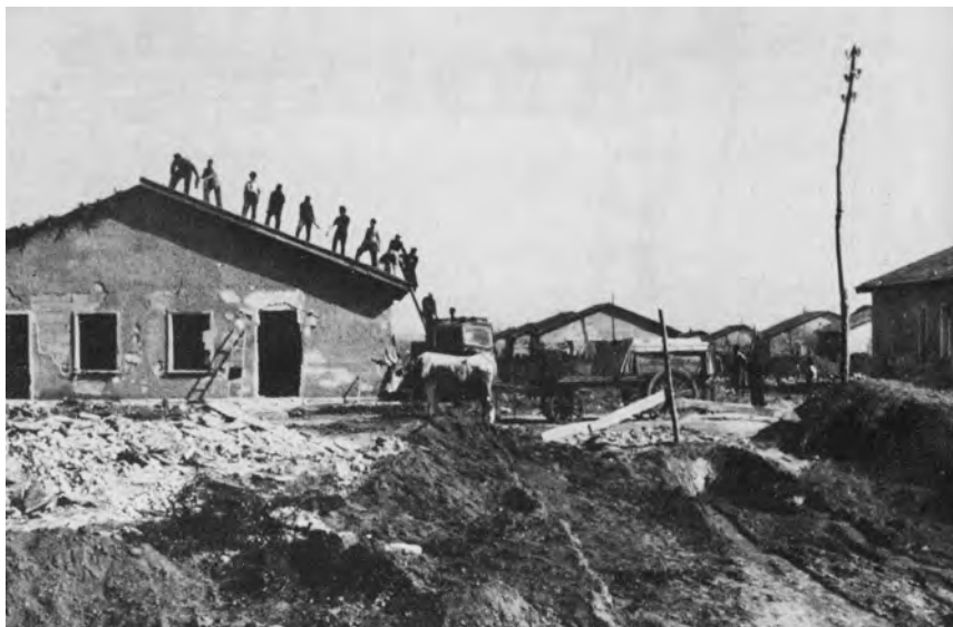
Case Pater in demolizione, dal libro Iacp di Roma, Documentazione di un periodo. Storia dell'Istituto dal 1903 al 1953, 1954
