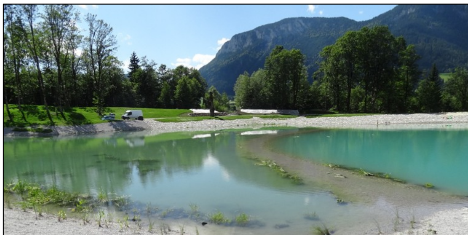
Abbildung 9: Der Ahornsee (Österreich) wird in einen Badebereich und einen Regenerationsbereich unterteilt. Damit sollen die Wasserqualität und das Speichervermögen gewährleistet werden. Foto: Klenkhart & Partner Consulting ZT GmbH.
