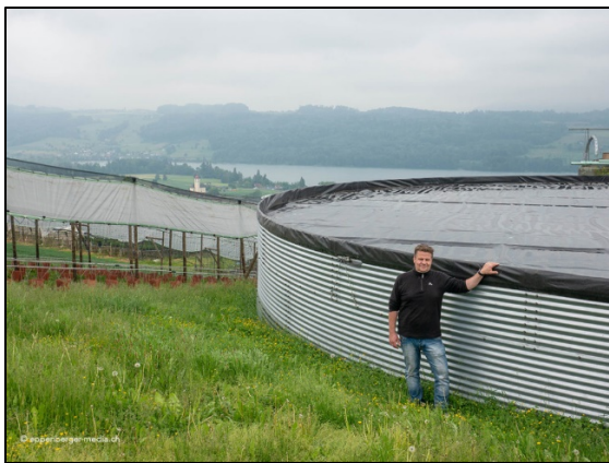
Abbildung 6: links: Stahlsilo bei einem Beerenproduzenten in Aesch LU mit 805 \text{ m}^3 Speicherkapazität (Eppenberger 2020); rechts: zwei kleinere Teiche klären das Wasser, bevor es in den grossen Bewässerungsspeicher ( 20.000 \text{ m}^3 ) fliesst, Gemüseproduzent in Deutschland (Foto: (Deter and Eghbal 2020) bioland-Fachmagazin).
