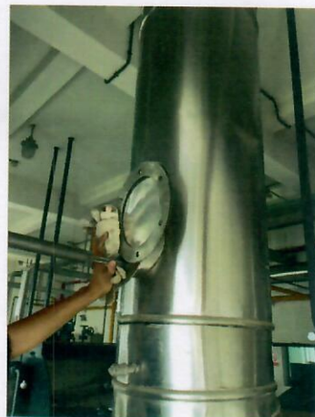
锅炉房楼顶排气筒 2#
