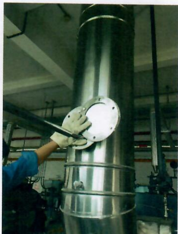
锅炉房楼顶排气筒 1#
