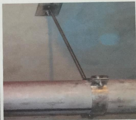
管道吊装固定
