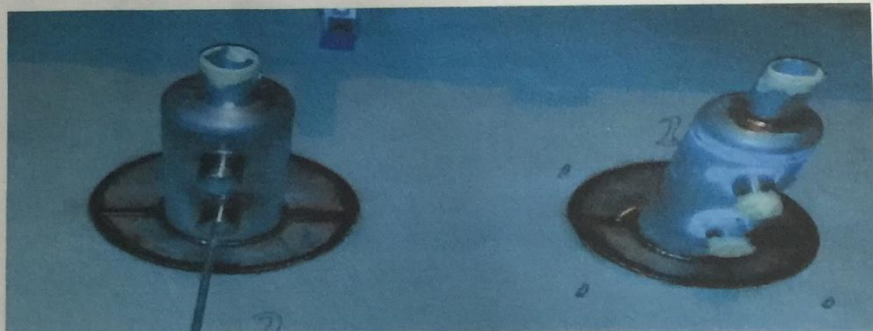
管道盖板焊接后采用 100%PT 检测焊缝密闭性
