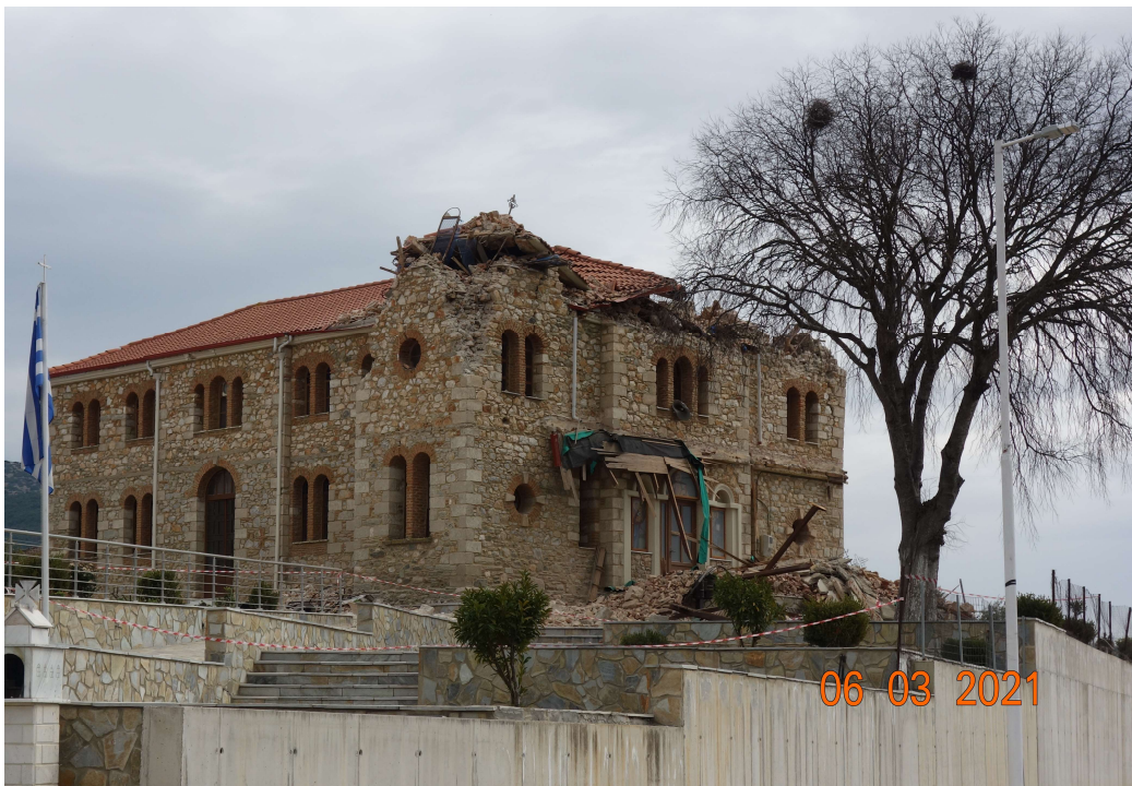
Εικόνα ΣΤΑ7. Βλάβες στον Ι. Ναό Αγίου Δημητρίου στο Μεσοχώρι. Άνω: Εικόνα με βλάβες από τον πρώτο ισχυρό σεισμό. Κάτω: Εικόνα με βλάβες μετά τον δεύτερο ισχυρό σεισμό.
