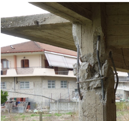
Εικόνα ΣΤΑ13. Βλάβες σε κτήριο με πυλωτή στο Δαμάσι. Οι βλάβες επικεντρώνονται στο άνω μέρος των υποστυλωμάτων πυλωτής.
