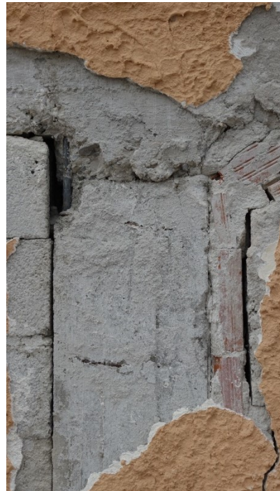
Εικόνα ΣΤΑ12 . Βλάβες σε κτήριο και δομικά μέλη από οπλισμένο σκυρόδεμα στο Δαμάσι.
