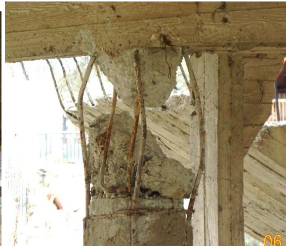
Εικόνα ΣΤΑ13. Βλάβες σε κτήριο με πυλωτή στο Δαμάσι. Οι βλάβες επικεντρώνονται στο άνω μέρος των υποστυλωμάτων πυλωτής.
