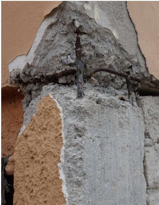
Εικόνα ΣΤΑ12 . Βλάβες σε κτήριο και δομικά μέλη από οπλισμένο σκυρόδεμα στο Δαμάσι.
