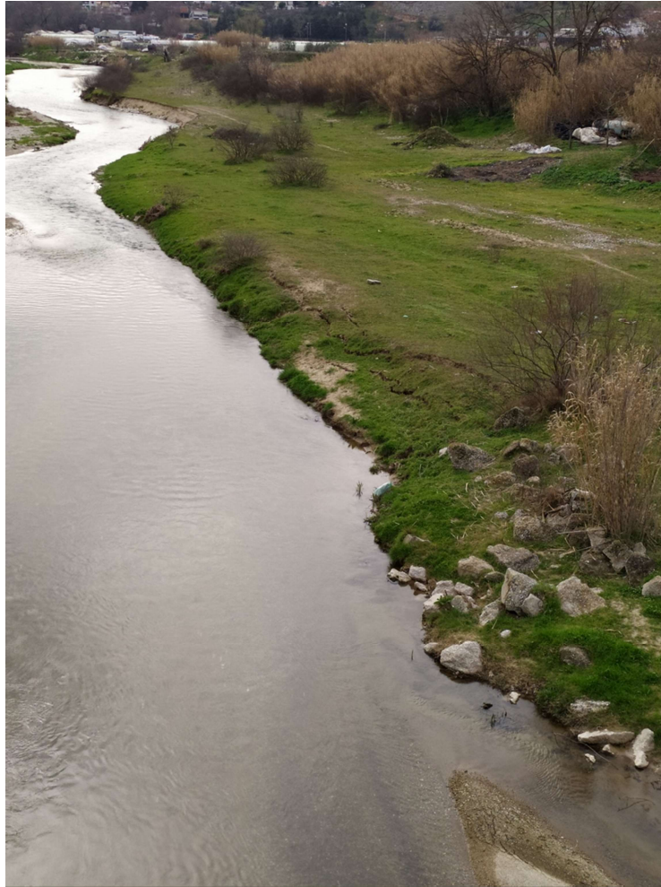
Εικόνα ΓΕΩ6. Φαινόμενα πλευρικής εξάπλωσης σε μικρό βαθμό κατά μήκος της κοίτης του ποταμού Τηταρήσιου (θέση κοντά στην γέφυρα εισόδου στο χωριό Δαμάσι, κινούμενος στην επαρχιακή οδό με κατεύθυνση από Τύρναβο προς Ελασσόνα) (Συν/νες θέσης φωτογραφίας: N39°42'58.46", E22°11'18.73")
