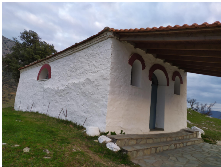
Εικόνα ΓΕΩ9. Παρεκκλήσι του προφήτη Ηλία το οποίο βρίσκεται σε λόφος ύψους περί τα 60m ανατολικά μεταξύ του ορεινού όγκου και του χωριού Ζάρκος: Παρά την έντονη τοπογραφική έξαρση στη θέση, το πέτρινο παρεκκλήσι δεν παρουσίασε βλάβες (Συν/νες θέσης φωτογραφίας: N39°36'21.48"; E22°7'50.81")
