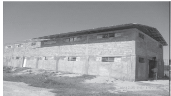
Figura 5. Obra civil para la protección del flujo tecnológico de la bioeléctrica.
