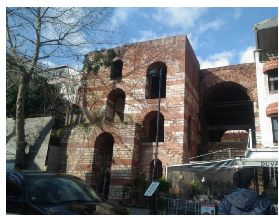
Fig. 7 La Casa de la rampa tras la restauración. Compárese con la fig. 5
