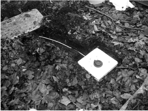
Abb. 2: Installation einer Kunststoff-Saugplatte auf dem Standort Langendreer in Bochum
