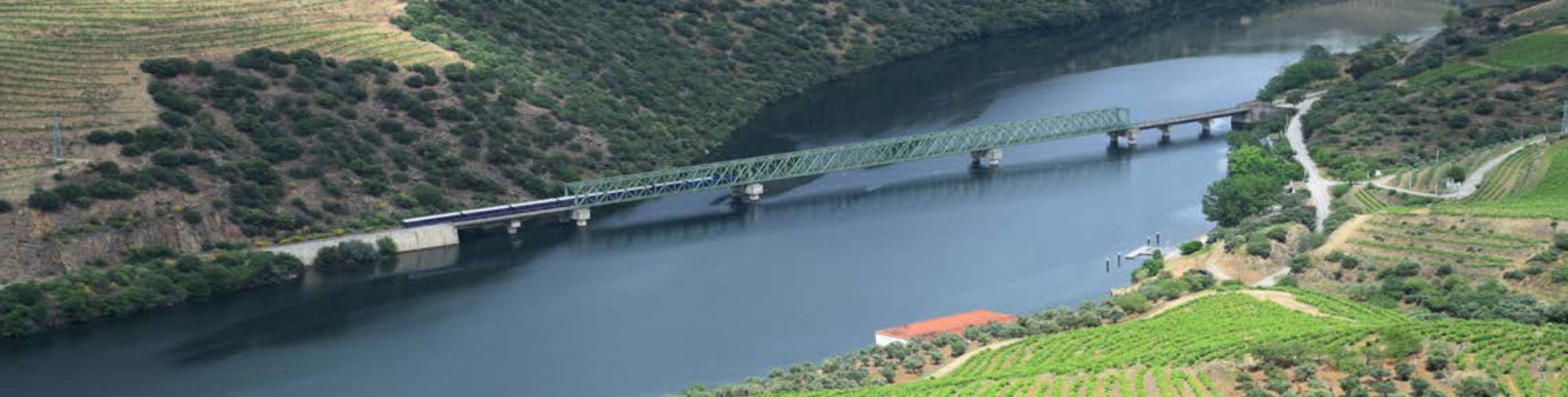
Fig. 9 Ponte da Ferradosa
