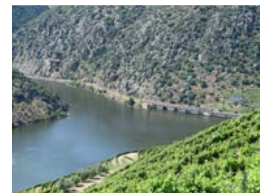
Fig. 6 Viaduto da Ferradosa
