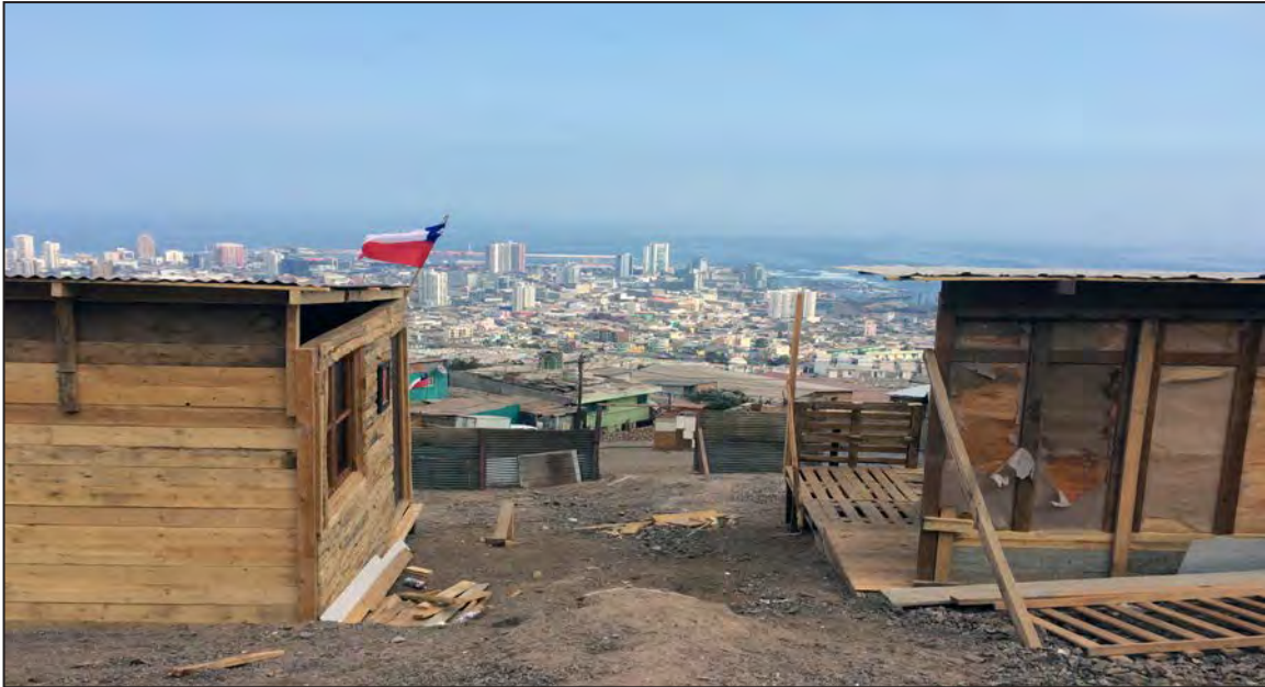
Fotografía N° 1. Viviendas en el proceso de autoconstrucción en un campamento al borde del cerro
