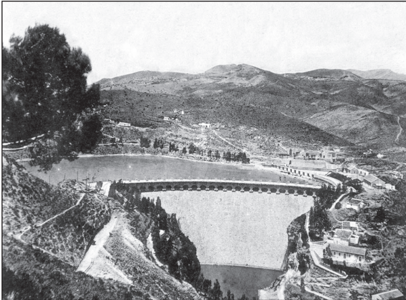
Fotografía N° 1. Presa del Conde de Guadalhorce, en Ardales, Málaga
