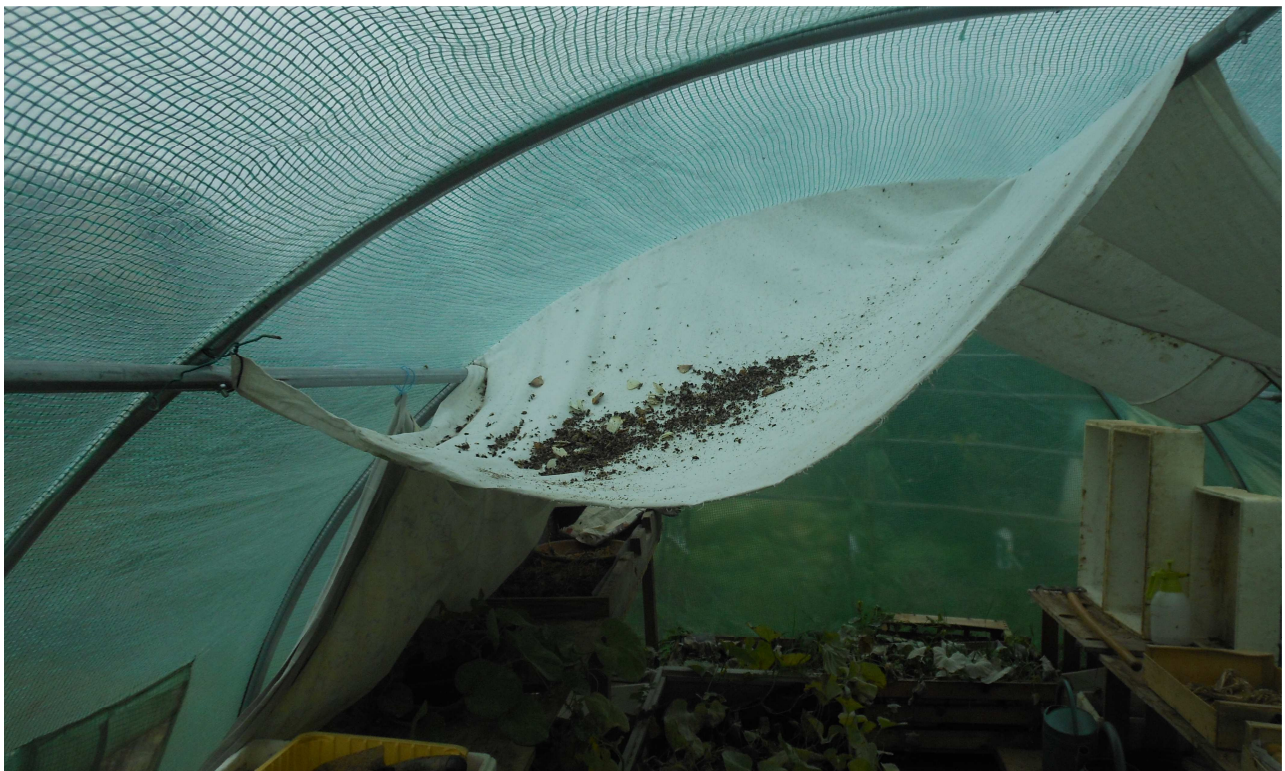
Figure 8. Serre numéro 1 à Saint-Aubin-du-Cormier Photo : P. JÉZÉQUEL 2018
