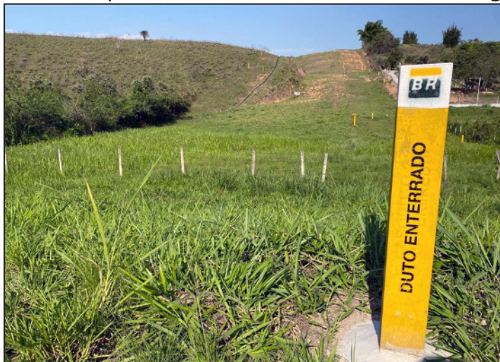
Fotografia N° 4. Dutos de petróleo cruzando a localidade de Tinguá
