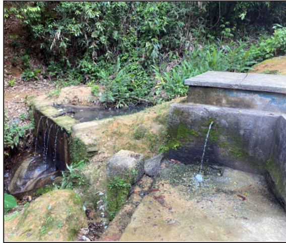
Fotografia N° 2. Fonte da Biquinha ao lado de córrego contaminado por esgoto
