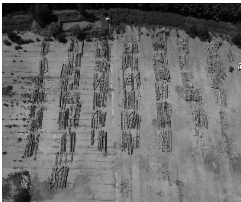
figure 16 · démontage sélectif de la structure métallique de la Halle Lustucru à Arles (a). Les éléments sont triés au sol (b).
