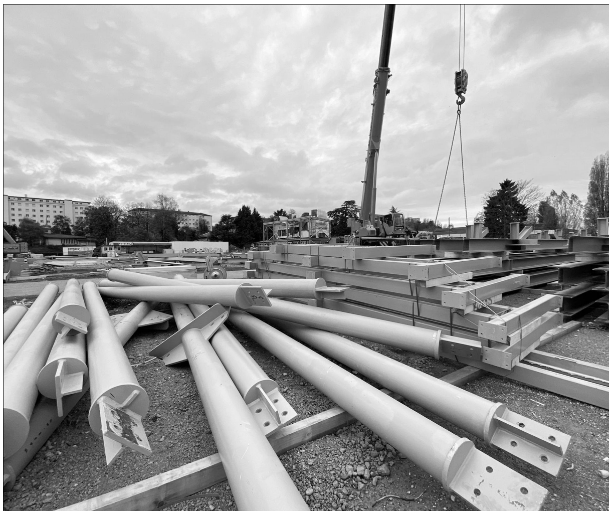
figure 11 · démontage de la patinoire provisoire de Malley (VD), 2020.
