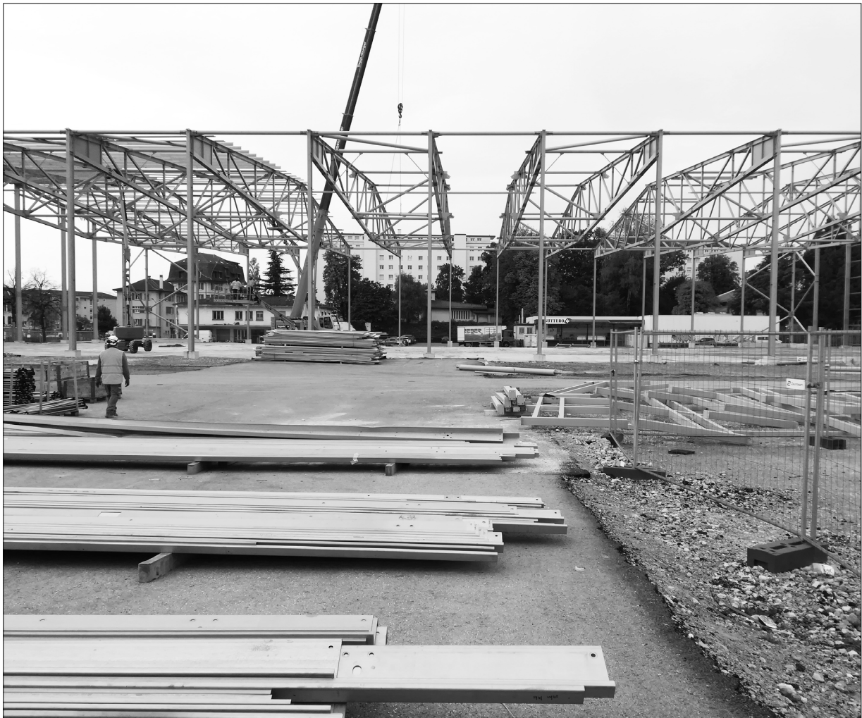
figure 21 · les qualités intrinsèques des structures métalliques sont favorables à leur longévité; ici à Lausanne, une structure est démontée pour réutilisation.
