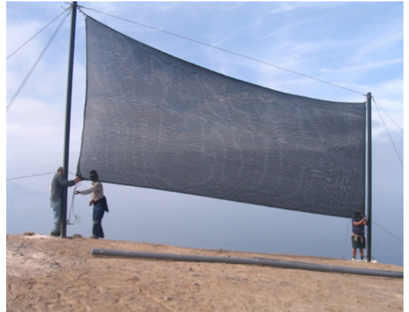
Figura 8. “Terminando de instalar un atrapanieblas de 40 m2 de malla raschel hacia los 800 msnm, en el oasis de niebla de Alto Patache, año 2007”. Fotografía de H. Larrain, Eco-antropología.blogspot.com
