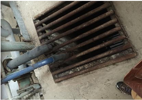
K. Urukumbuzi II sewer pipes
