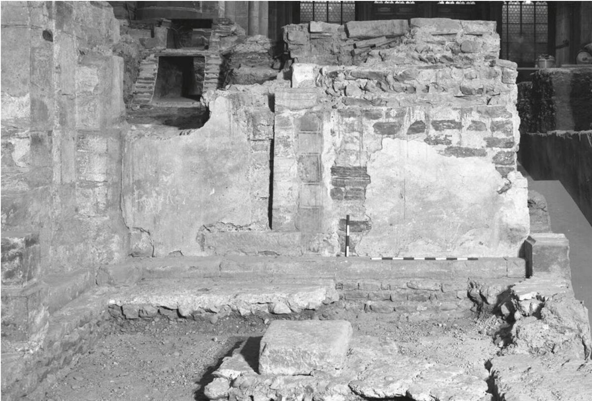
**B.9:** Vierungskrypta SW-Ecke. Westwand, Südteil, nach Beseitigung der gotischen Seitentreppe und des gotischen Verputzes an der Westwand. In der Ecke Rest des ottonischen Mörtelbodens, davor Stützenfundament 523
