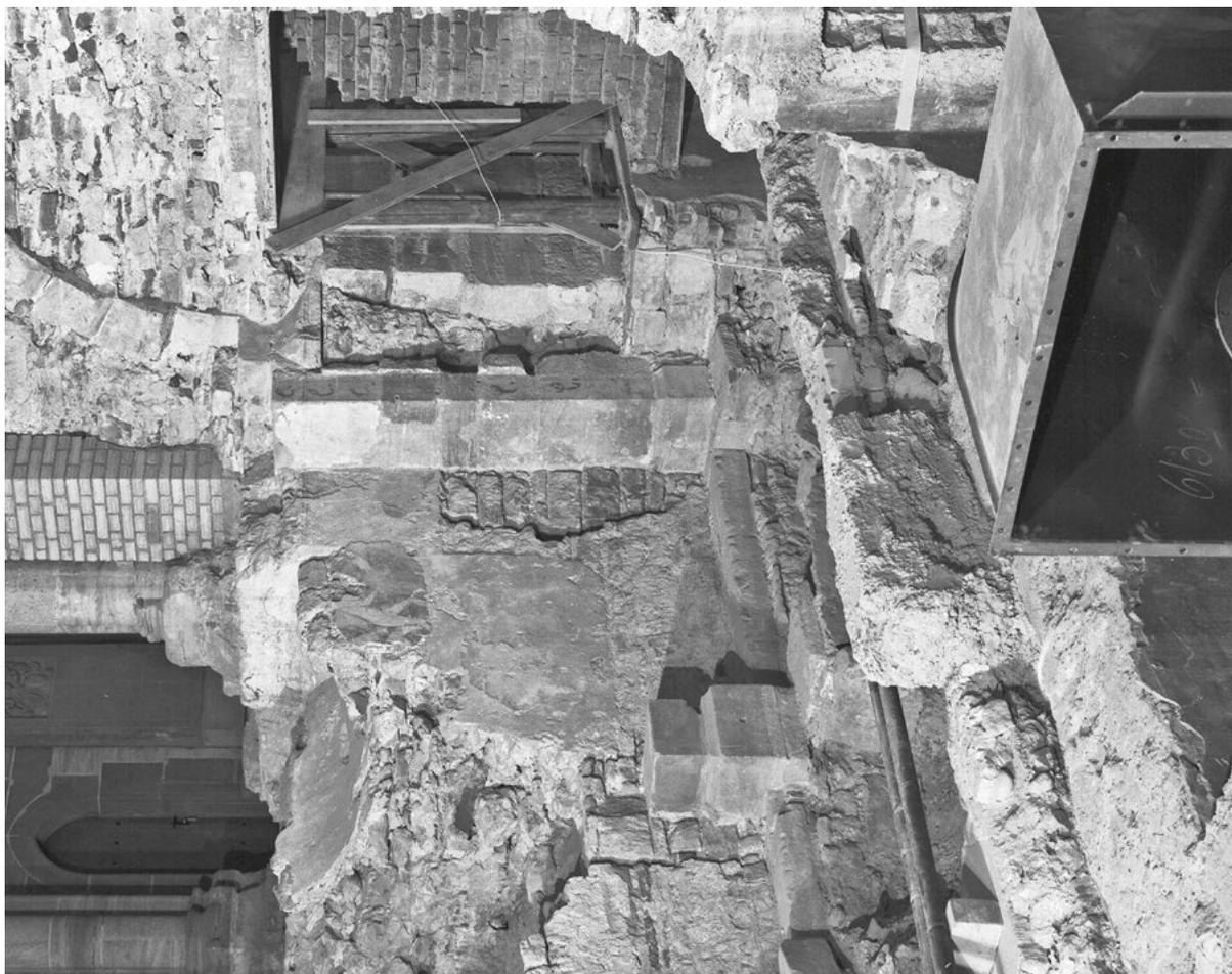
**B.20:** Vierungskrypta gegen NE. Im Vordergrund und unter dem Gewölbegurtbogen rechts Heizungsmauerwerk und -Installationen. Links karolingisch-ottonische Nordmauer der Vierungskrypta mit gotischem Verputz und Wandmalereien. Auf der Mauerkrone dahinter Mulde der romanischen Biforen-Fensterbank
