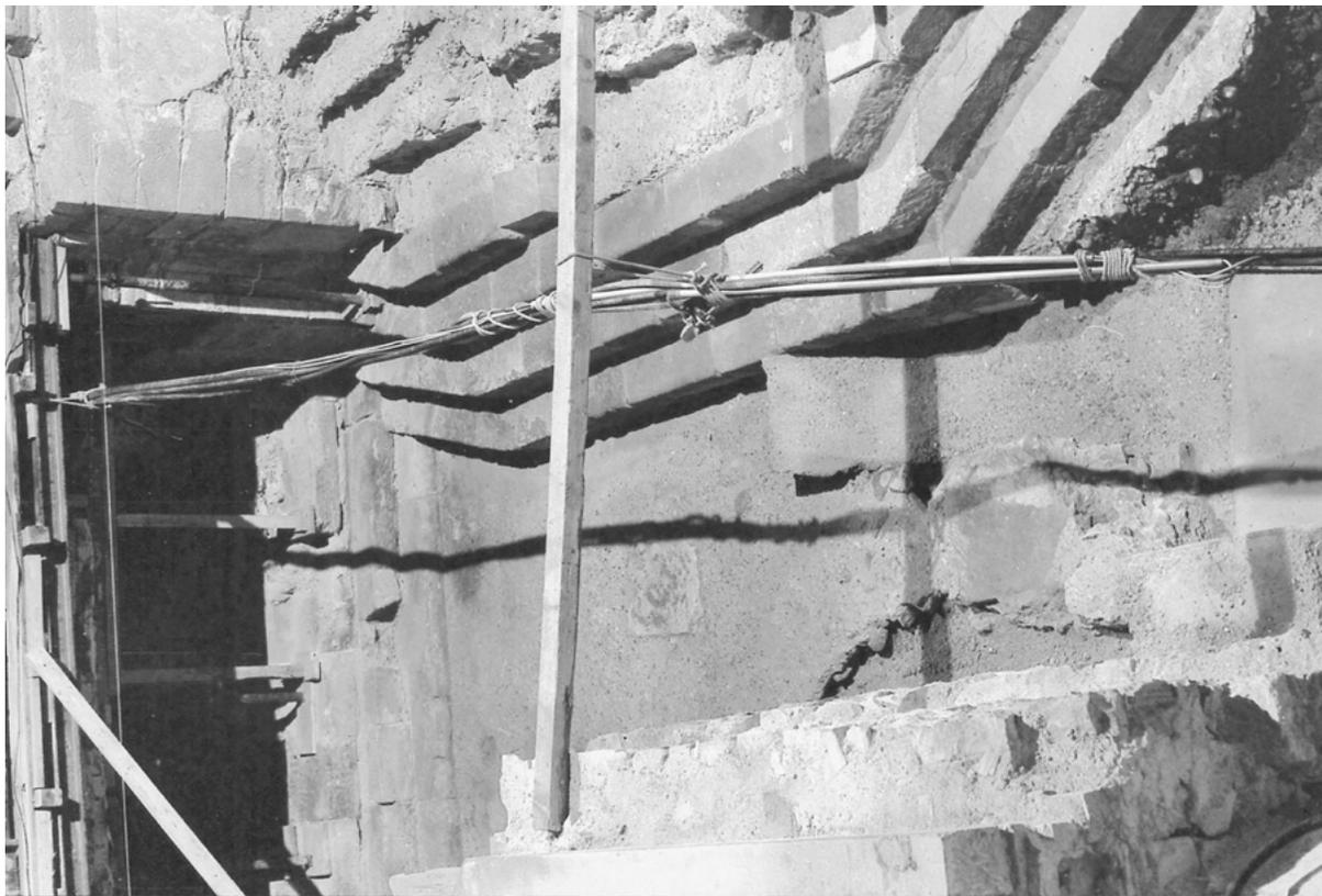
**B.19:** Vierungskrypta Nordseite. Rechts gotische Seitentreppe, Mörtelboden mit Stützenfundament, links Heizungsmauer
