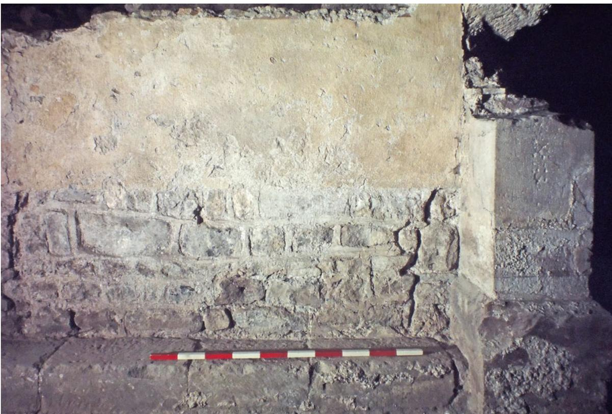
**B.14:** Vierungskrypta Süd-mauer, Ostabschnitt. Ottonische Mauer mit Mörtelstegen, darüber gotischer Verputz
