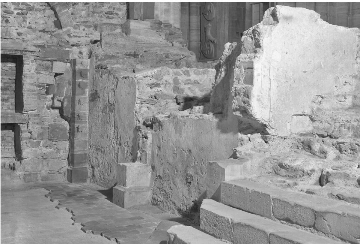
**B.10:** Vierungskrypta SE-Ecke. Gotische Seitentreppe, Wandvorlage, gotischer Tonplattenboden. An die Wandvorlage in der Ecke schliesst links Mauerwerk des Heizungseinbaues an
