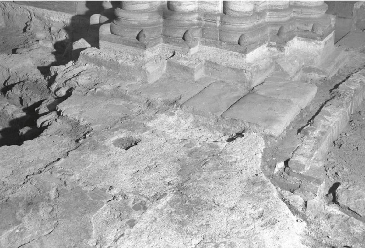
**B.1:** Nordquerhaus, Ostmauer, von SW. Der romanische Plattenboden stösst an die 1850 heruntergespitzten Sockelsteine der romanischen Bündelpfeiler. Die romanischen Degerfelderplatten **40** liegen unmittelbar auf dem ottonischen Mörtelboden **17** (Heinrichsboden), dessen Oberfläche z. T. für dickere Platten zurückgearbeitet wurde. Rechts anschliessend Grab **32/66**
