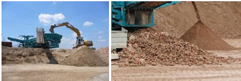
Slika 9: Prvi korak obdelave CDW - drobljenje in magnetno ločevanje
