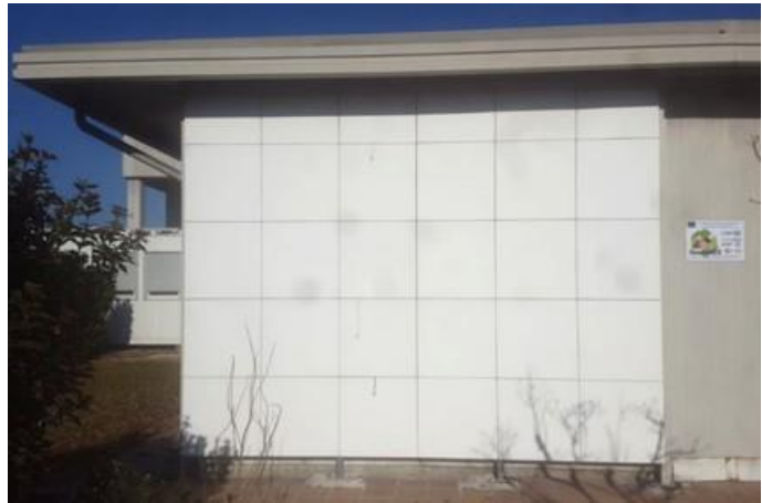
Slika 64: Plošče za prezračevane fasade, vgrajene na južno steno pilotne hiše
