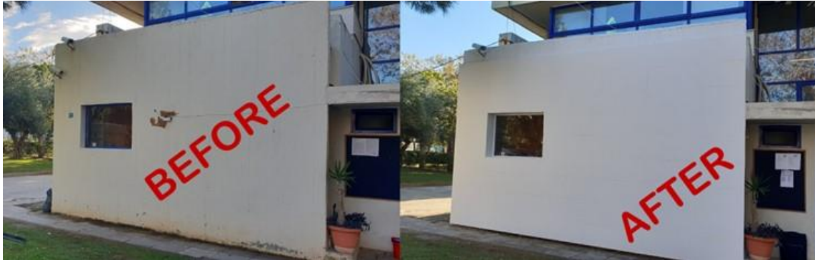
Slika 71: Plošče za kontaktne izolativne fasade, vgrajene na grško pilotno mesto
