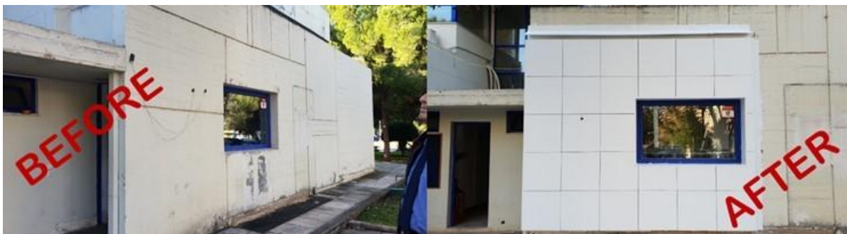
Slika 72: Plošče za prezračevane fasade, vgrajene na grško pilotno mesto
