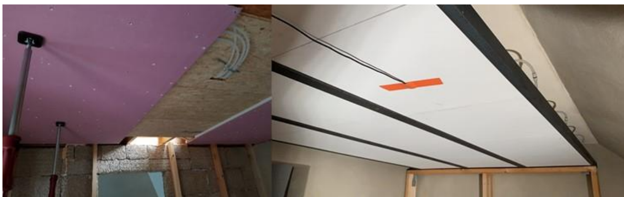
Slika 79: Konkurenčni izdelek (levo) in sevalne plošče InnoWEE (desno), vgrajene na strop
