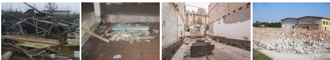
Slika 8: Slike z gradbišč z izvedenim selektivnim rušenjem
