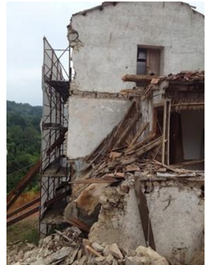
Slika 7: Primer gradnje za selektivno rušenje
