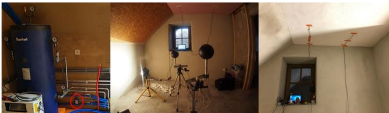
Slika 80: Oprema za spremljanje za merjenje učinkovitosti stropnih sevalnih plošč
