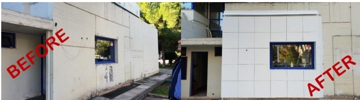
Ryc. 72. Wentylowane panele elewacyjne zainstalowane w greckim demonstratorze
