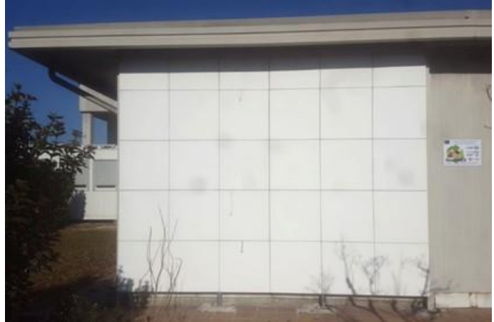
Ryc. 64. Wentylowane panele elewacyjne montowane na południowej ścianie domu pilotażowego
