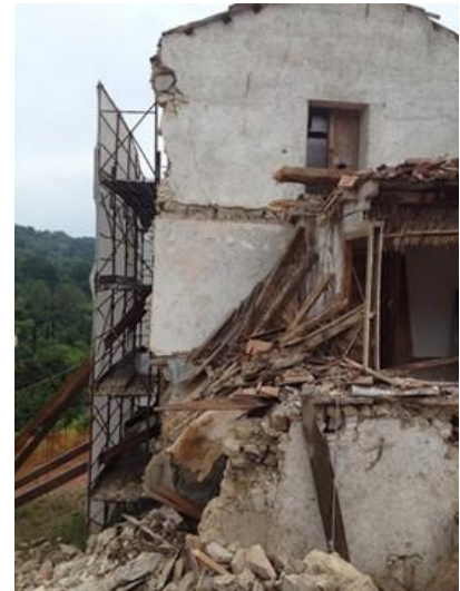
Ryc. 7. Przykład budynku do selektywnej rozbiórki
