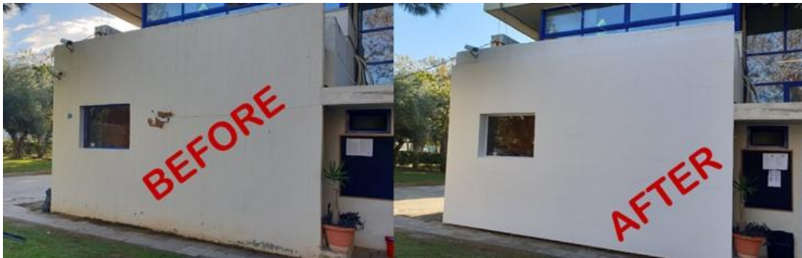
Ryc. 71. Panele ETICS-podobne zainstalowane w greckim budynku demo
