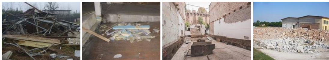
Ryc. 8. Obrazy z placów budowy z trwającymi selektywnymi wyburzeniami
