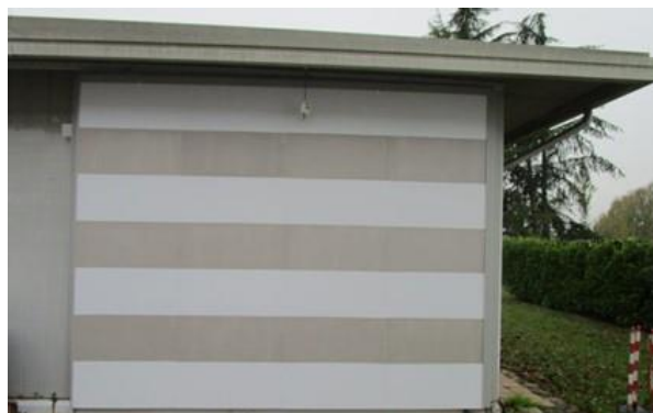
Ryc. 63. Panele ETICS-podobne zainstalowane na północnej ścianie domu pilotażowego
