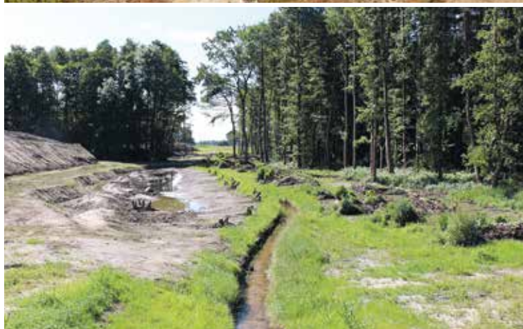
Abb. 7: Herstellung einer Sekundäraue an der Großen Mühlenhase im Landkreis Osnabrück (oben) und im Schierenbach Landkreis Vechta (unten)
