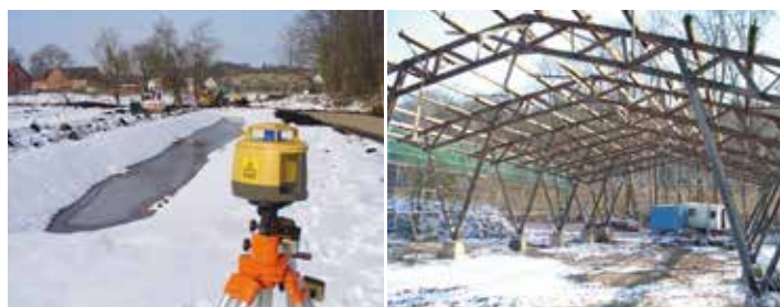
Abb. 4: Neubau- und Sanierungsarbeiten
