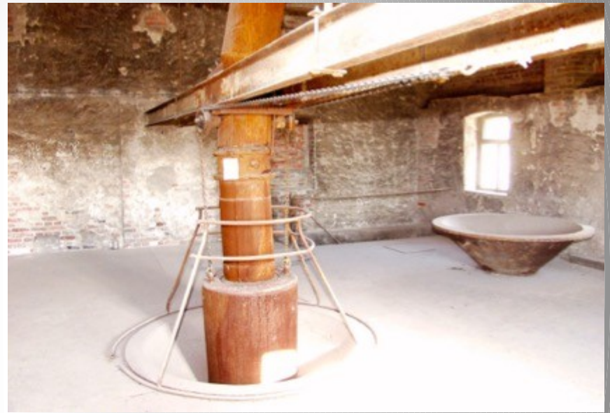
Gichtbühne mit Befüllvorrichtung
