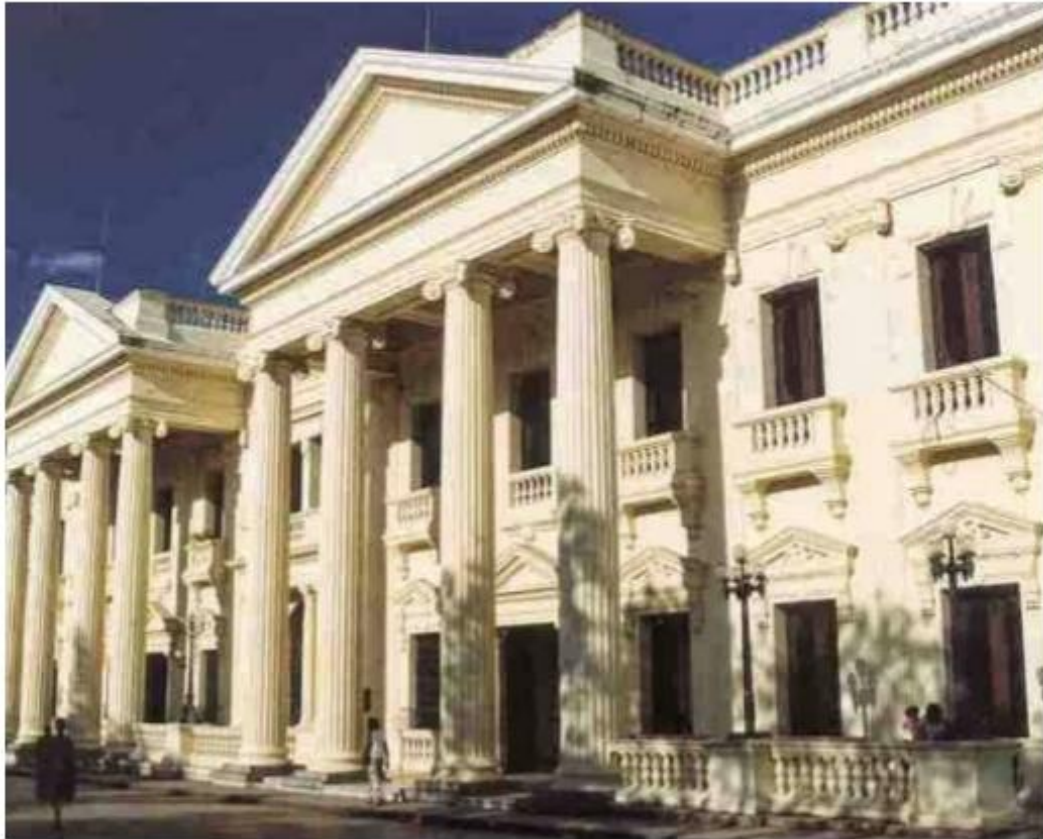
Ilustración 5: Fachada de la Biblioteca Provincial Martí de Villa Clara (fuente: elaboración propia).
