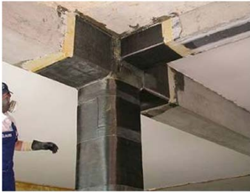
Figura 18. Sistema RFP (manto fibra carbono)
