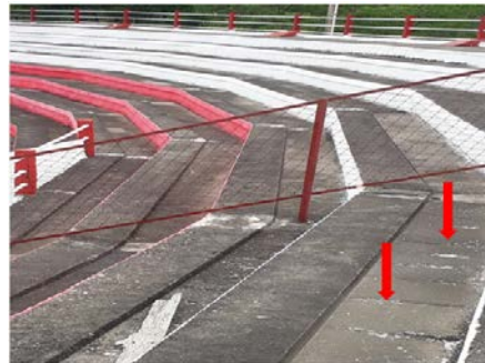
Figura 10. Graderías a la intemperie
