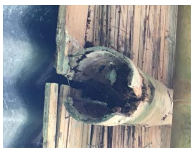
Figura 4. Ataque de termitas e insectos coleópteros
