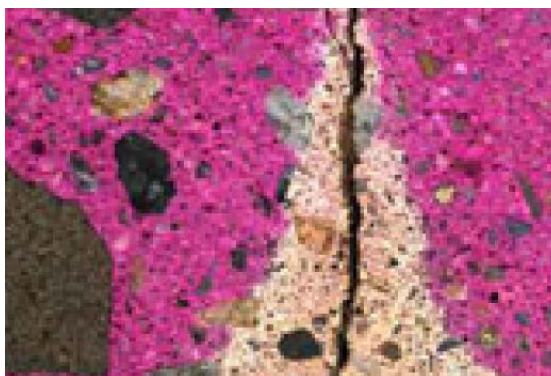
Figura 8. Ensayo de Carbonatación
