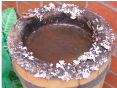
Figura 5. Guadua afectada por hongos
