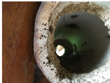
Figura 3. Ataque por insectos cromógenos
