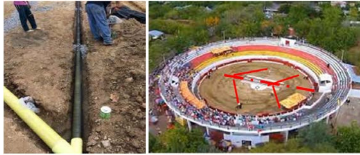
Figura 15. Esquema de drenaje espina de pescado [3]
