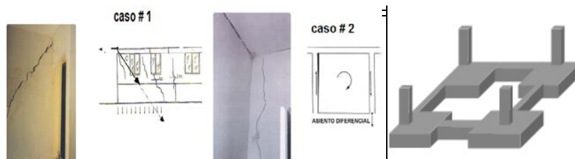
Figura 14. Grietas por asentamiento diferencial en zapatas
