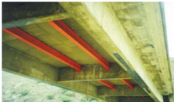
Figura 19. Reforzamiento con adición de perfiles
