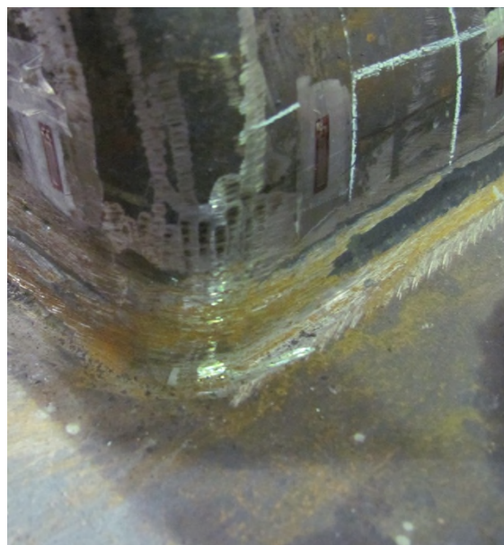
(d) Welding at north east corner
