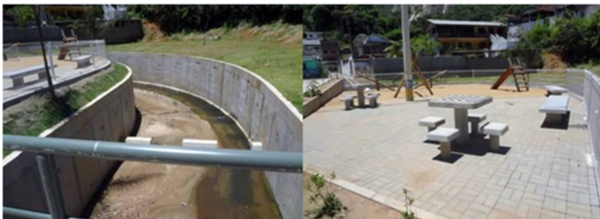
Fotografias 2 e 3. Obras no bairro Caleme.
