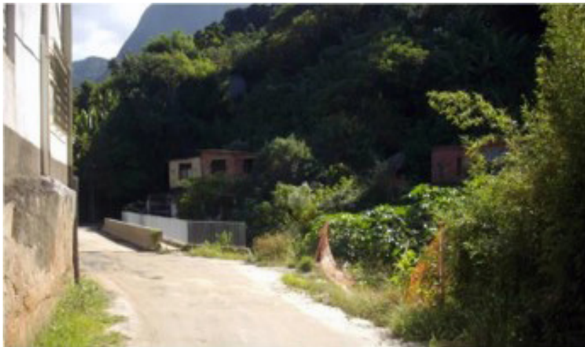
Fotografia 1. Construção da ponte no bairro Caleme.
